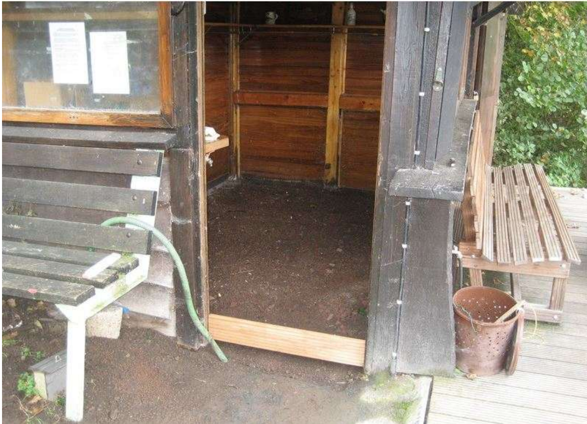
Die Angelhütte vor der Renovierung 2013. Foto: Lothar Krupp
