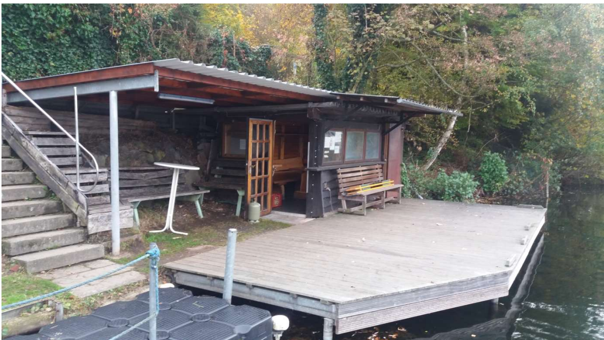
2016 Die oberen Dacharbeiten nach der Fertigstellung. Es fehlt noch die untere Verkleidung an der Hütte. Foto: F. Marten
