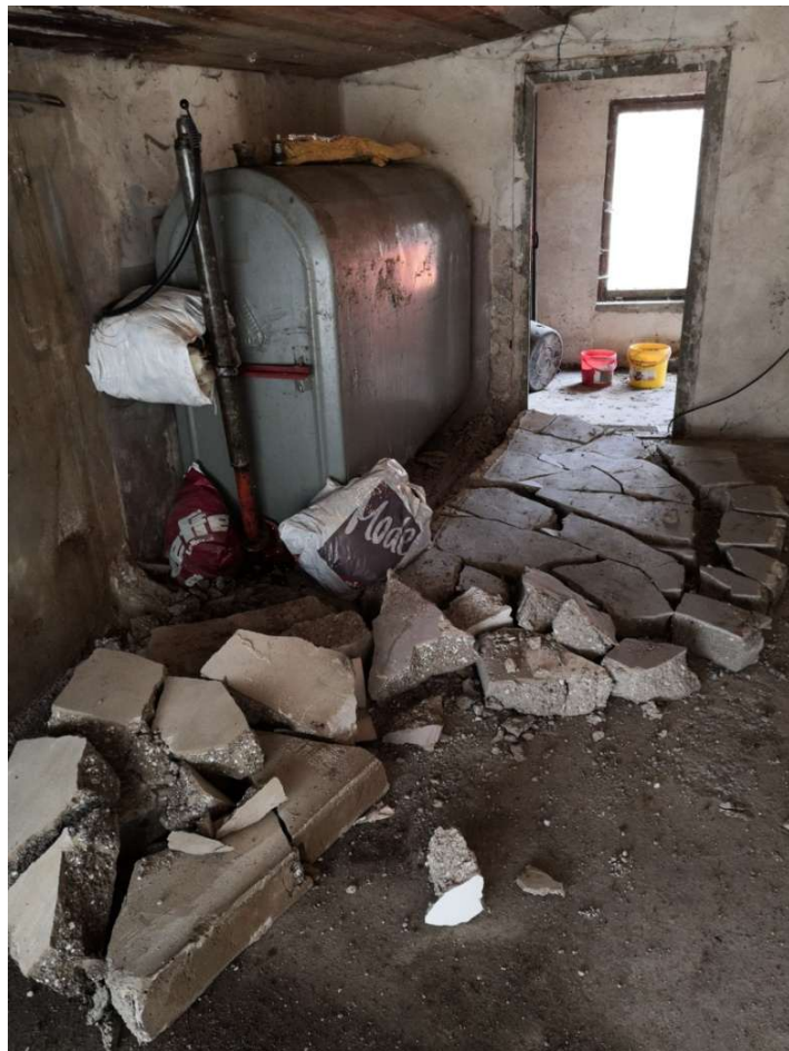
04.03.2020 Ausbau des Öltanks im „Schuppen“.Foto: Frank Marten
