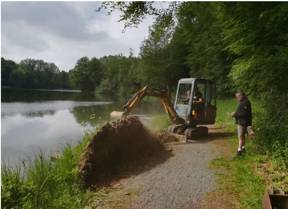
2018 Wegbaggern des stehen gelassenen Wurzeltellers im Juni 2018 . Im Bagger: Daniel Lux, rechts Michael Zimmer. Foto: Frank Marten
