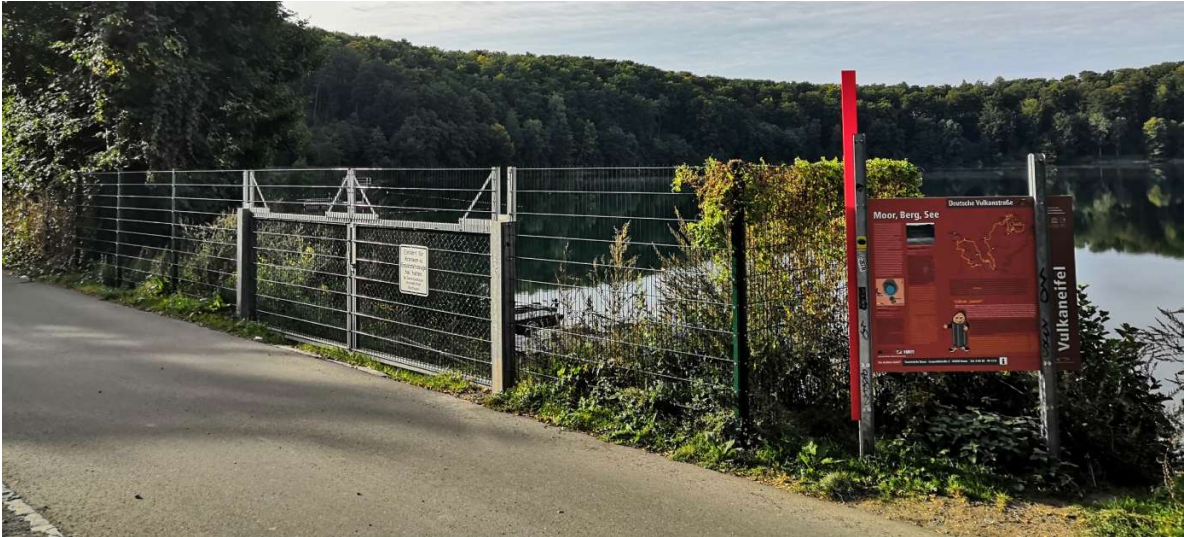
2019 Die fertige Zaunanlage für die Feuerwehr und Rettungskräfte. Foto: Frank Marten
