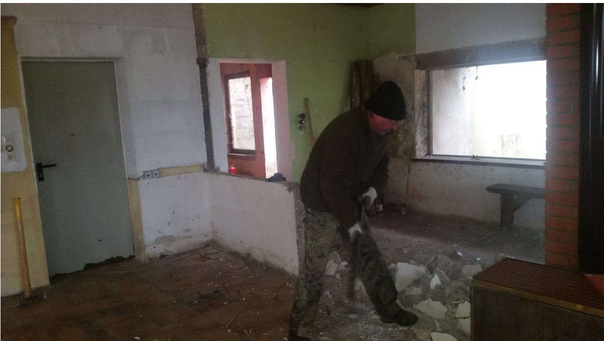
06.03.2020 Abriss der Trennwand. Lothar Krupp, hinten der KK-Schießstand. Foto: Michael Zimmer
