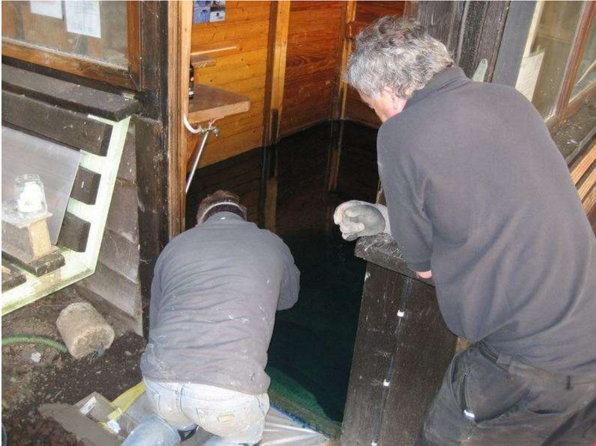
Michael Zimmer beim beschichten des Bodenbelages in der Angelhütte. Thomas Neukirch macht die Bauaufsicht. Foto: Lothar Krupp
