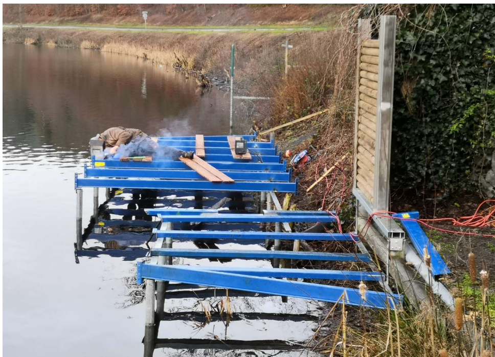
14.12.2019 Bau des Feuerwehr und Rettungssteg, Frank Reth am schweißen. Foto: Frank Marten
