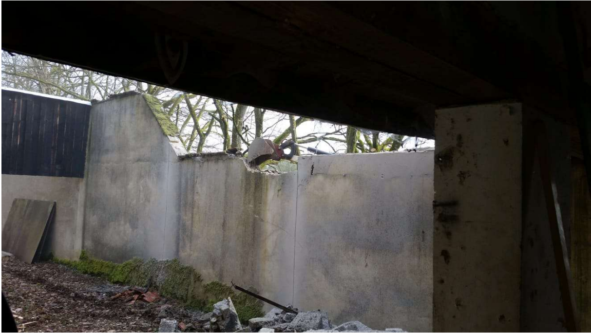
14.03.2020 Abriss der Kugelschutzmauer für Zugangsöffnung zum Schießstand. Foto: Frank Marten
