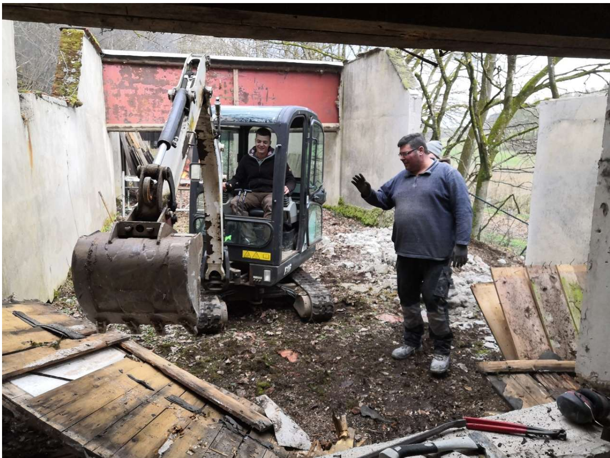
14.03.2020. Abrissarbeiten im Schießstand. Maximilian Lenerz im Bagger, Marc Hohns vorne, dahinter Jonas Zimmer. Foto: F. Marten
