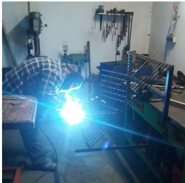
2016 Thomas Schneider, Gillenbeuren, beim Bau des neuen Wasser-Ablaufschutzes für den Mönch am Holzmaar. Foto: Frank Marten
