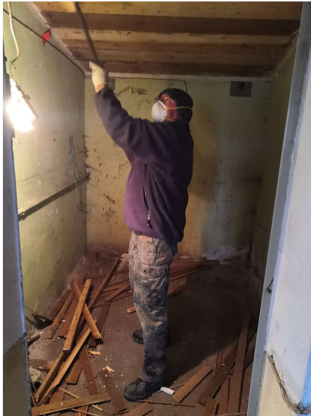
13.03.2020 Lothar Krupp bei Abrissarbeiten in der „Spülküche“. Foto: Frank Marten
