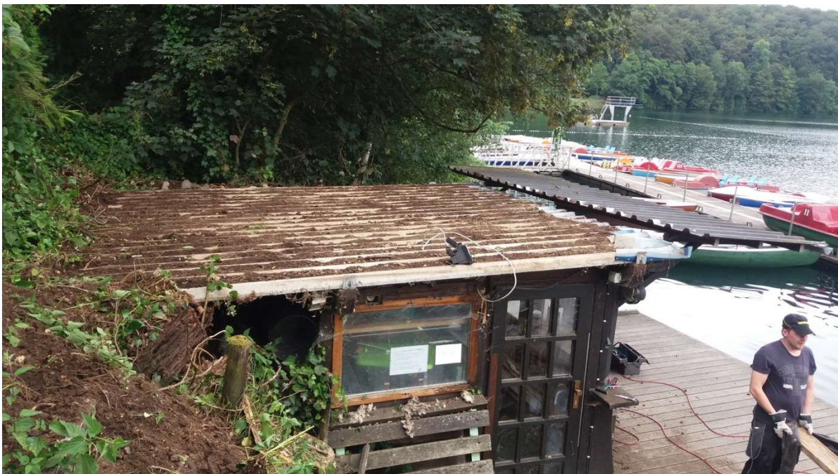
2016 Nach dem Abriss. Unten rechts im Bild: Frank Reth. Foto: Frank Marten
