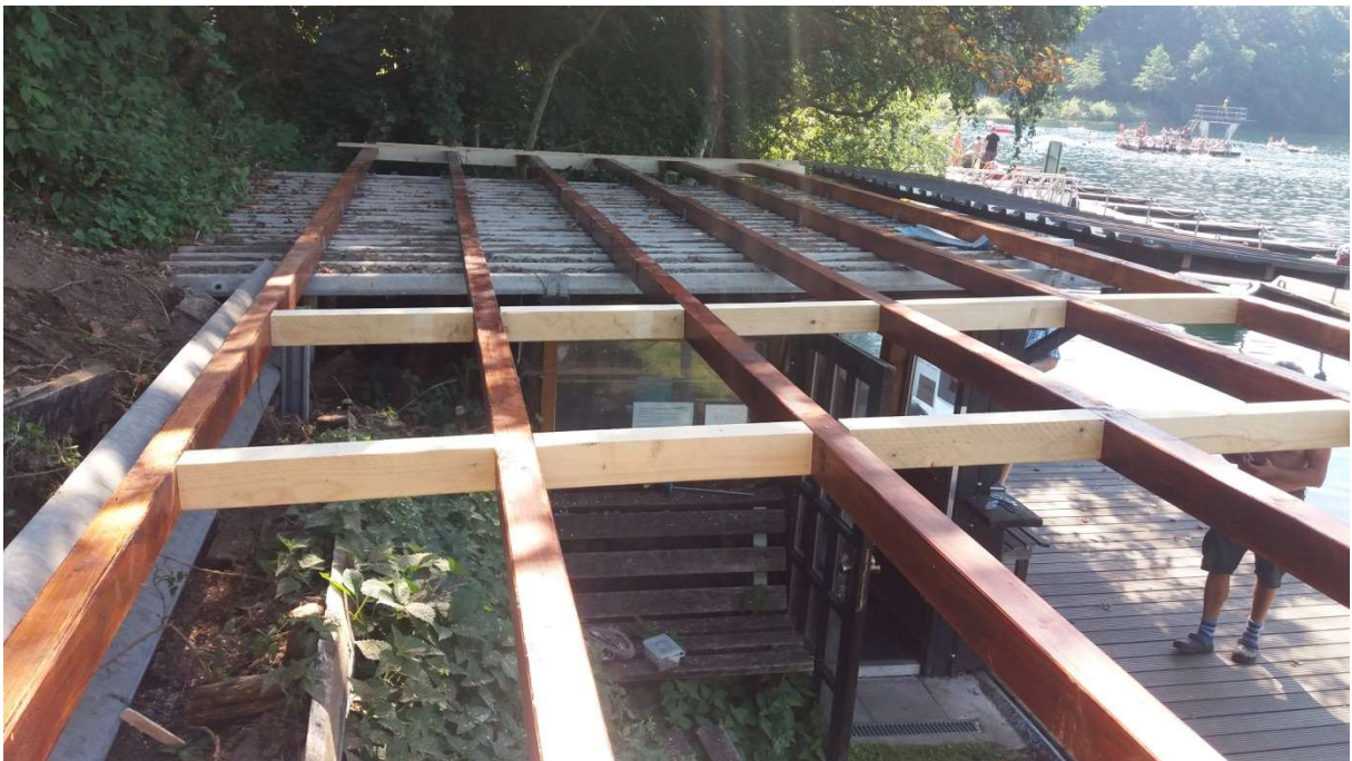
2016 Neue Dachkonstruktion am Angelsteg am Pulvermaar. Foto: F. Marten
