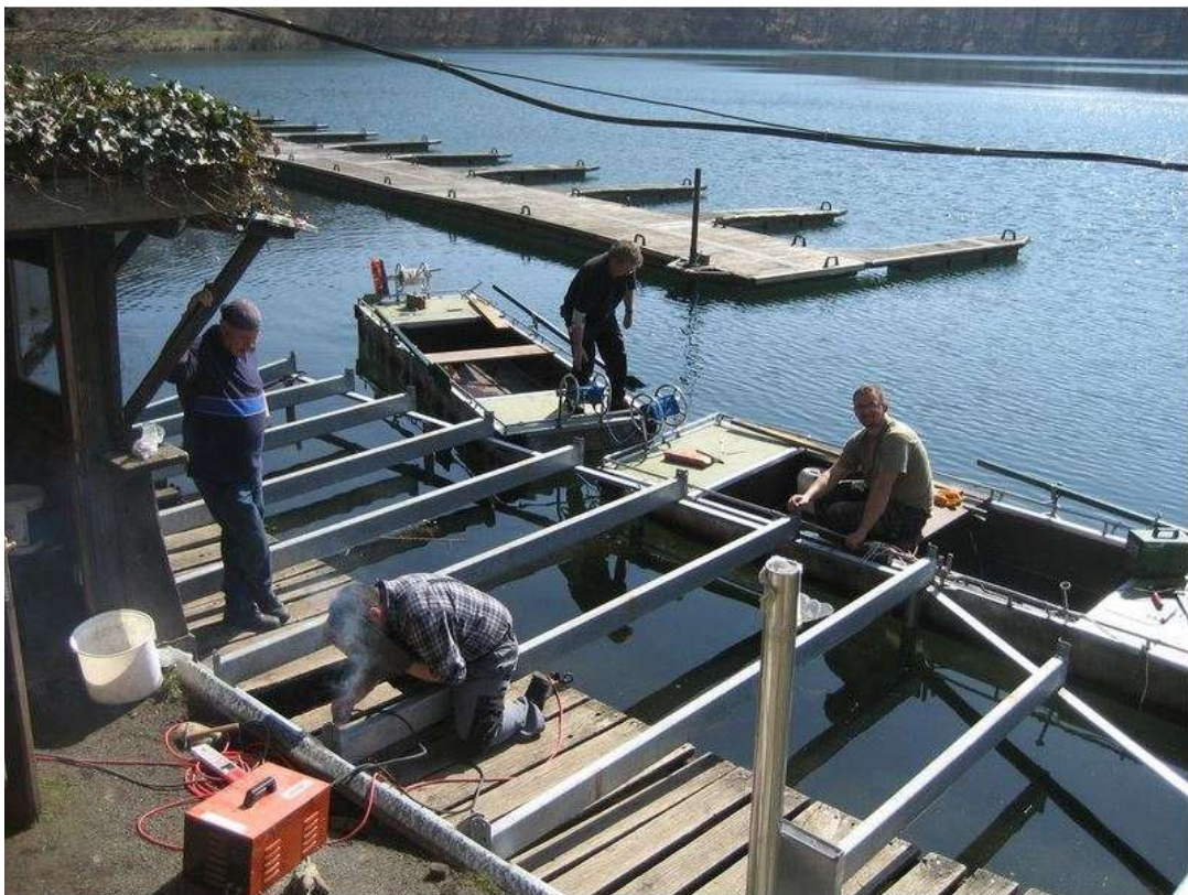
Bau der neuen Unterkonstruktion. V.l.n.r. Werner Still, Thomas Ternes, Thomas Neukirch, Rafael Miczka. Foto: Lothar Krupp
