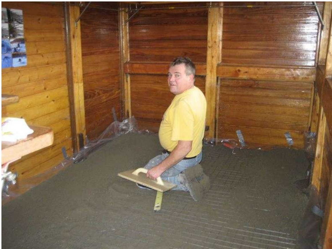
(Michael Zimmer beim Einbau des Estrichs in der Angelhütte. Foto: Lothar Krupp)
