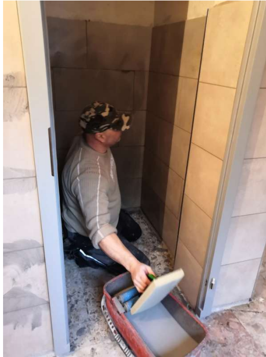
06.02.2021 Emil Hermann beim verfugen der Fliesen im WC
