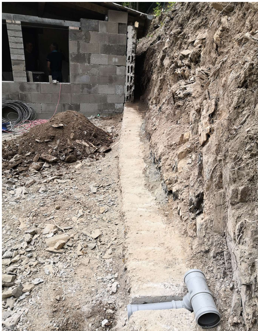
09.05.2020 Vorbereitung für die Schalmauer im Schießstand. Foto: Frank Marten
