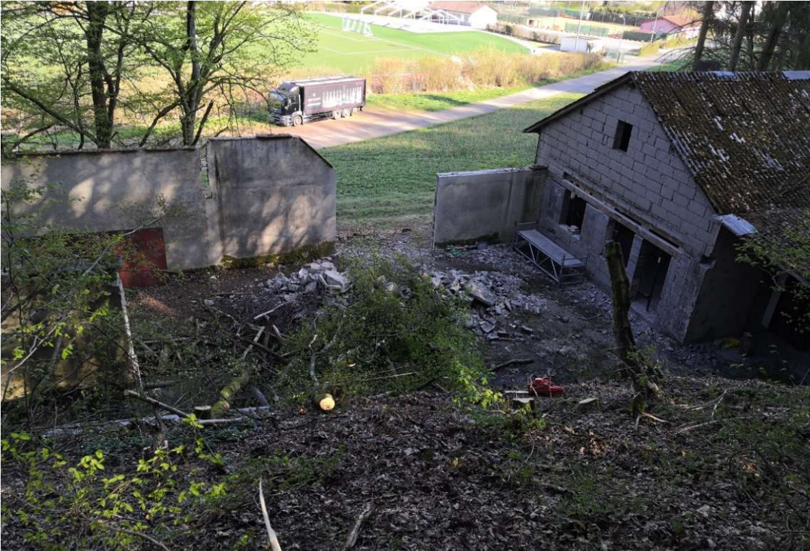
24.04.2020 Fällarbeiten im Hang. Am Haus ist der halbe Stein zum hochsetzen des Holzsturzes schon ausgestemmt. Foto: Frank Marten
