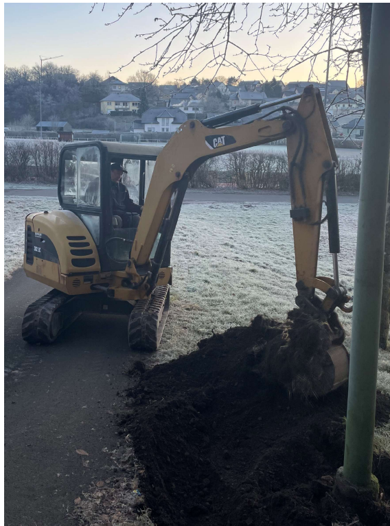
Maik Thome beim ausschachten für die Kabelanbindung der unteren Straßenlampe. Foto: Frank Marten
