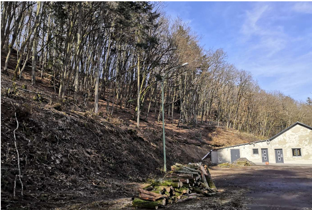
22.02.2021 Der Vorplatz und im hinteren Bereich der Hang nach den Abholzarbeiten. Dem Wald hatten die letzten zu trockenen Jahre schwer zugesetzt. Foto: Frank Marten
