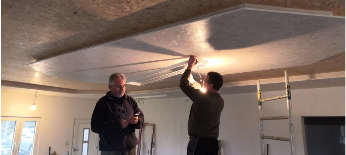
09.12.2020 Lothar Krupp und Andreas von Ameln bei der Montage der LED-Panel im großen Raum. Foto: Frank Marten
