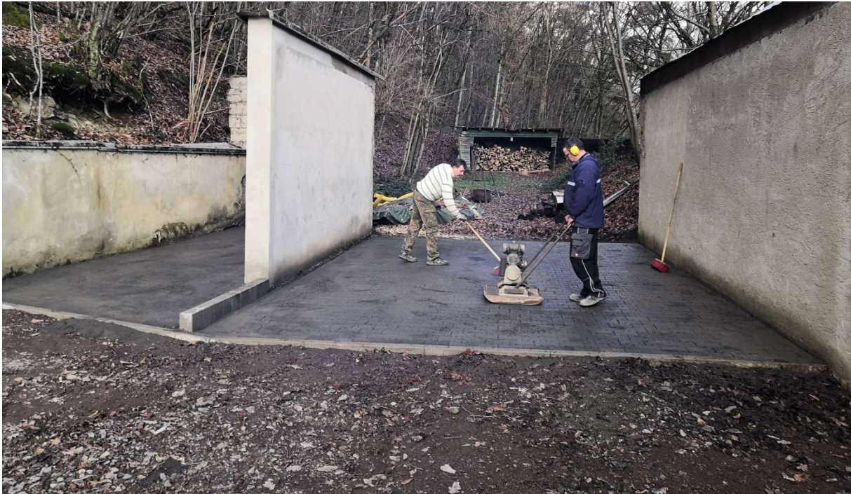
05.12.2020 Lutz Musiol und Andreas von Ameln beim einkehren und abrütteln der Pflasterfläche im alten Schießstand. Foto: Frank Marten
