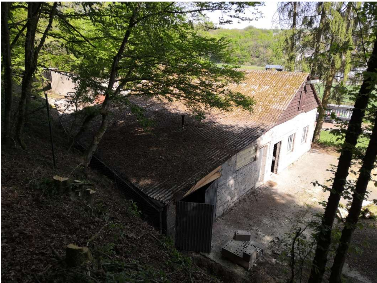
Anglerheim 24.04.2020 vor Fällarbeiten um die Dachfläche von Überhängern zu befreien. Foto: Frank Marten
