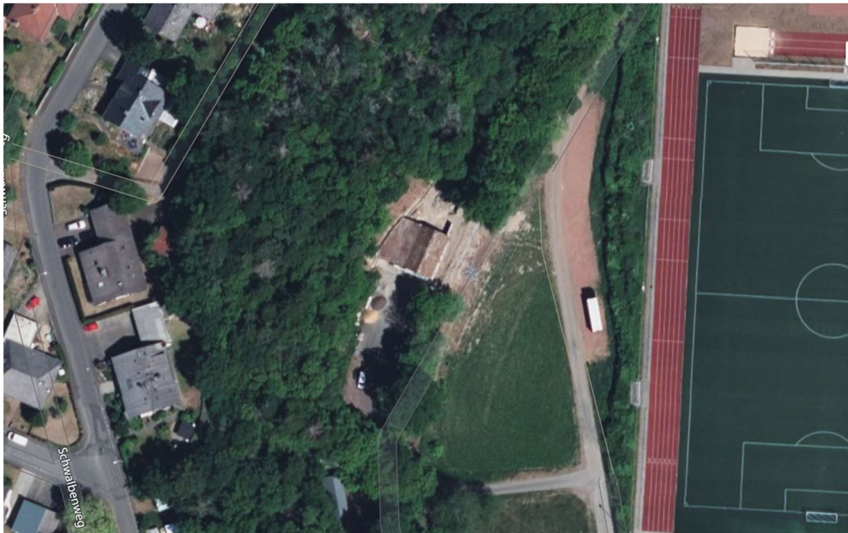
März 2022. Satellitenfoto Bing. Umbau des Schützenhauses. Noch alte Bedachung. Gebäude wurde schon freigeschnitten und Baustoffe liegen auf dem Vorplatz.
