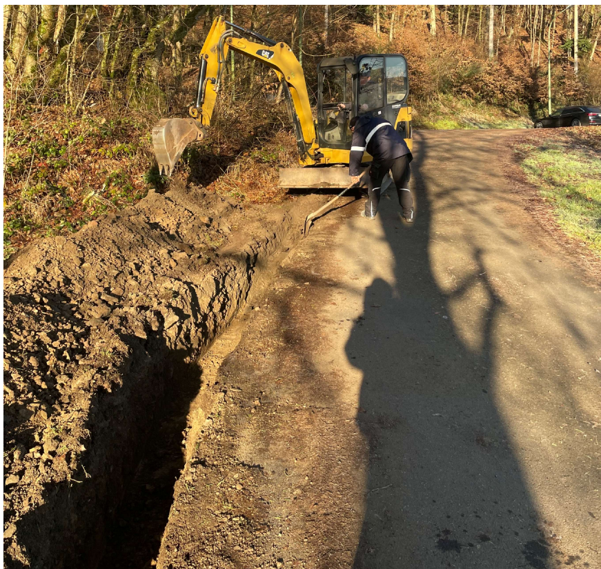
Maik Thome und Emil Hermann beim ausschachten zur oberen Straßenlampe. Foto : Frank Marten
