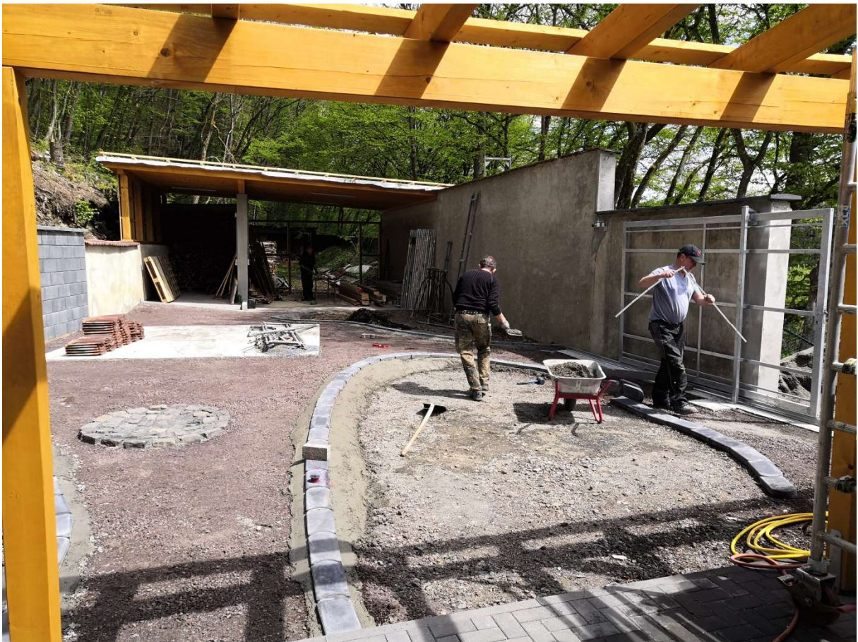
21.05.2021 Lutz Musiol und Andreas von Ameln beim anlegen der Grünflächen. Im Hintergrund unter dem Schleppdach werkt Lothar Krupp die hintere Wand mit dem Tordurchlass. Foto: Frank Marten
