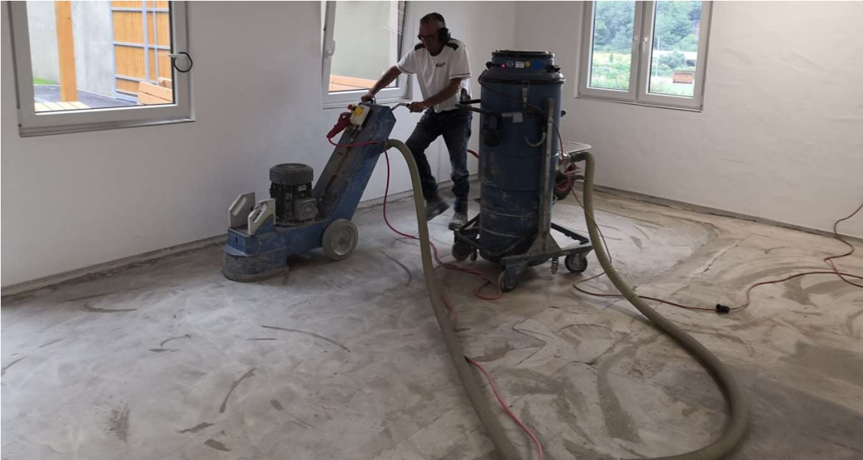
12.07.2021 Michael Zimmer beim abschleifen des Estrichs für die Bodenbeschichtung. Foto: Frank Marten
