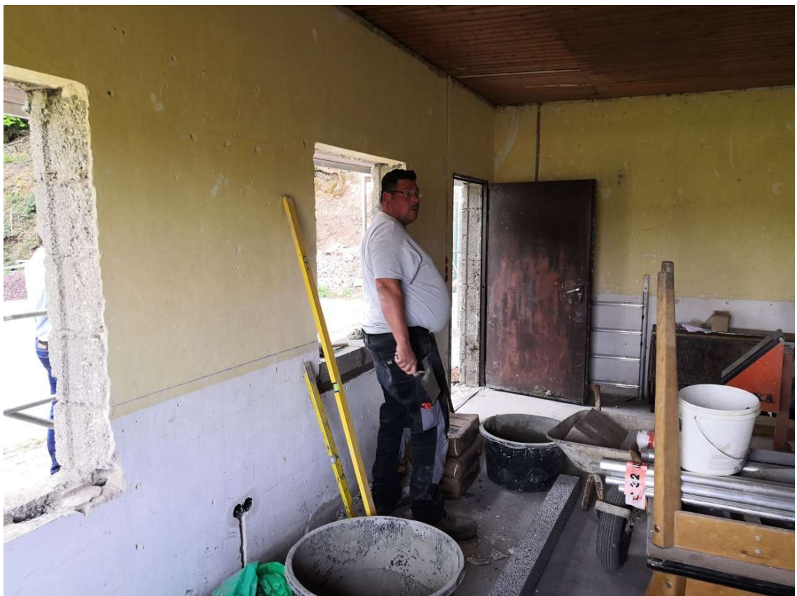
08.05.2020 Marc Hohns beim abmauern der Fenster. Foto: Frank Marten
