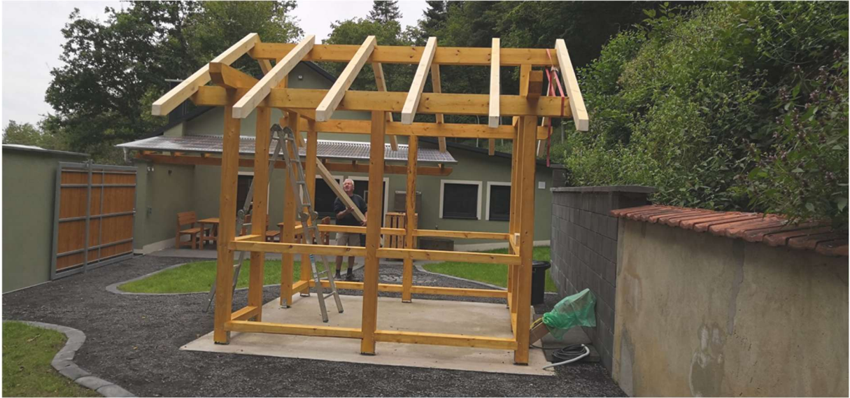
17.08.2021 Lothar Krupp beim aufschlagen der Dachkonstruktion der Grillhütte im Innenhof des alten Schießstandes. Foto: Frank Marten
