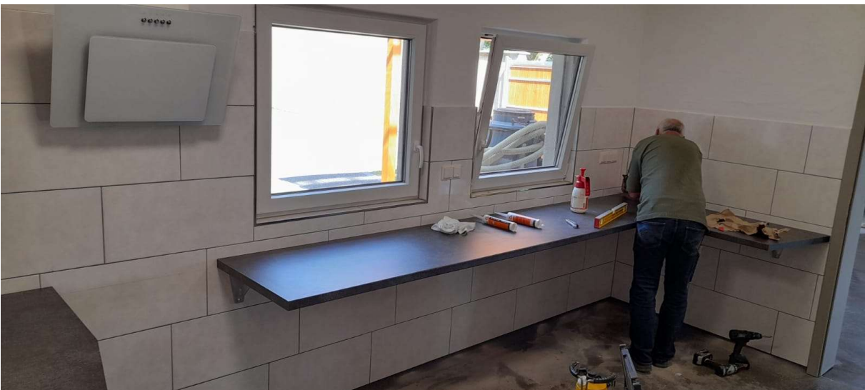
19.07.2021 Rainer Görres beim montieren der Arbeitsplatten in der Küche. Foto: Lothar Krupp
