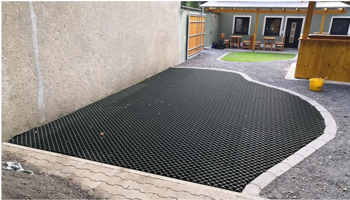
25.09.2021 Die beiden Rasenflächen wurden mit Rasengitterwaben erneuert, mit der Hoffnung, hiermit den Rasen zu erhalten, da unser Versuch, nur Rasen mit einer Matschfläche endete. Foto: Frank Marten
