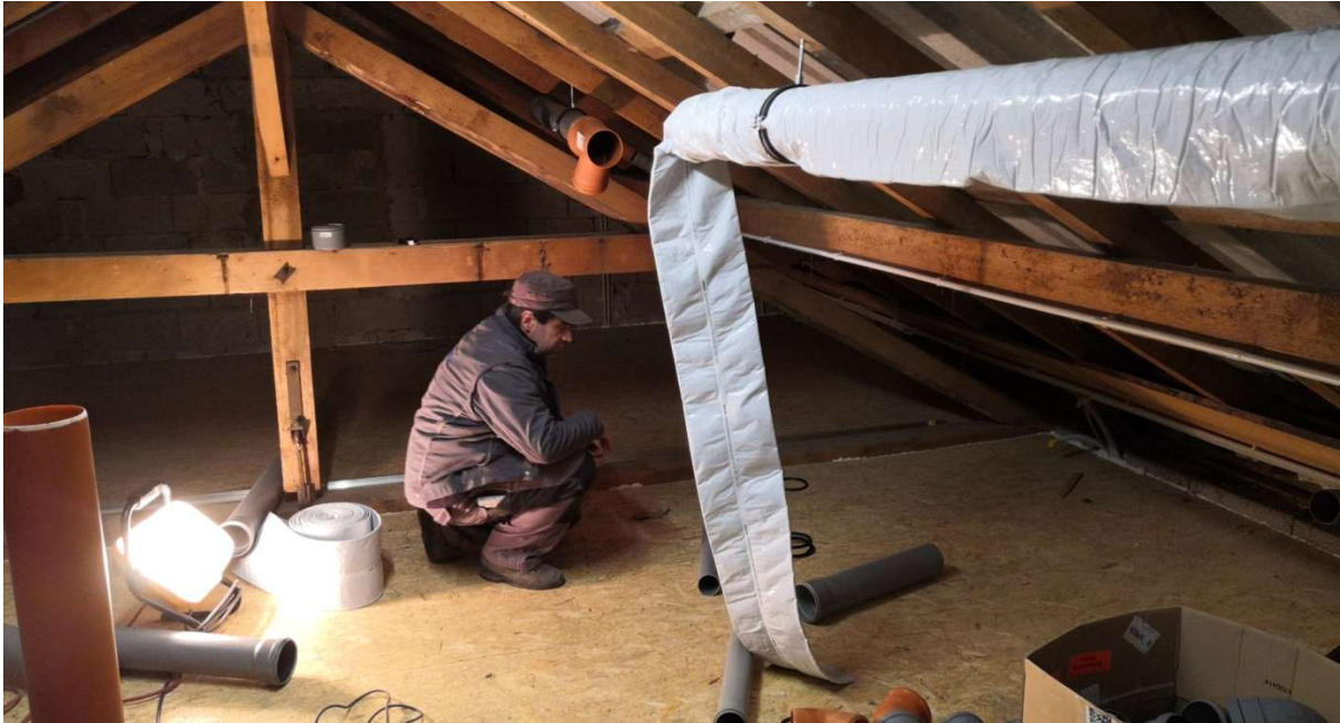
28.12.2020 Thomas Ternes beim Errichten der Lüftungsanlage auf dem Dachboden des Anglerheim. Durch diese Lüftungsanlage wird eine selbständige tägliche Durchlüftung des gesamten Gebäudes gewährleistet. Foto: Frank Marten
