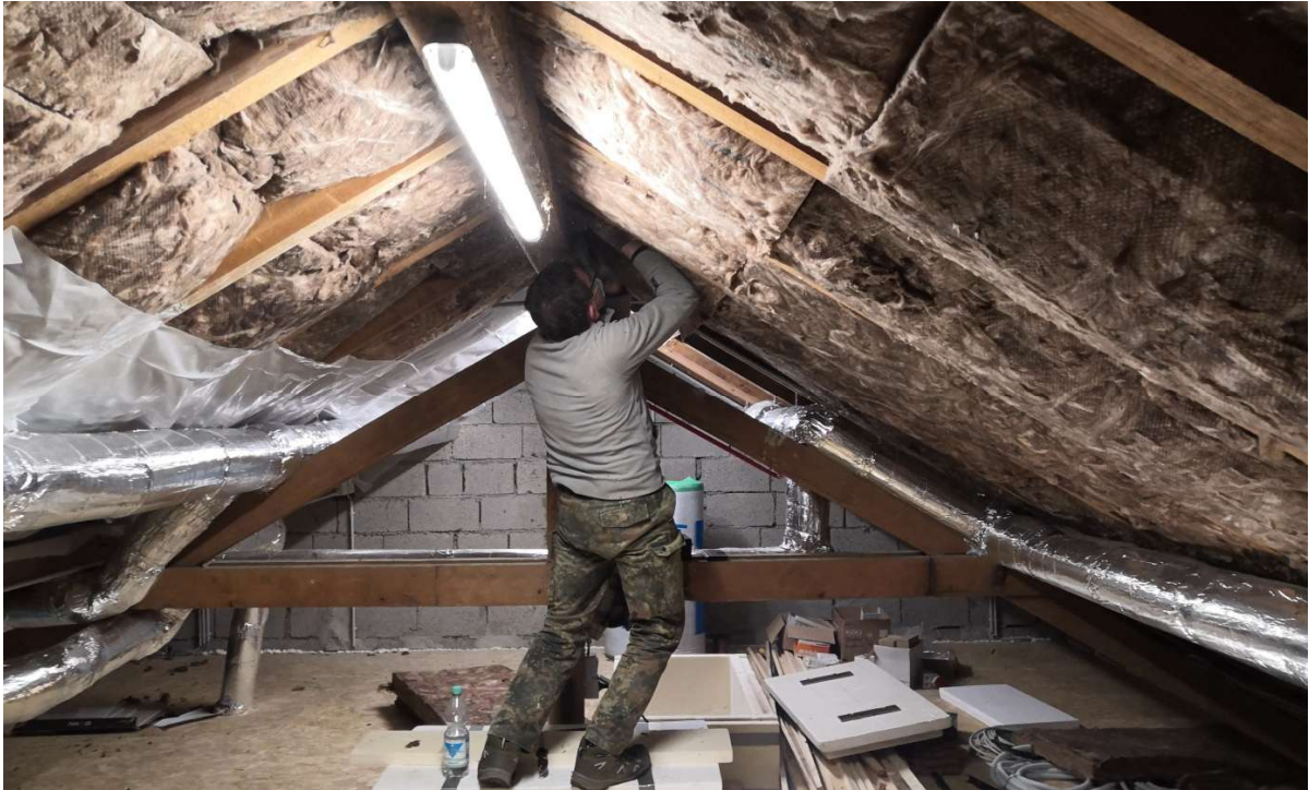
02.12.2021 Lutz Musiol beim isolieren des Dachstuhles vom neuen Anglerheim. Foto: Frank Marten
