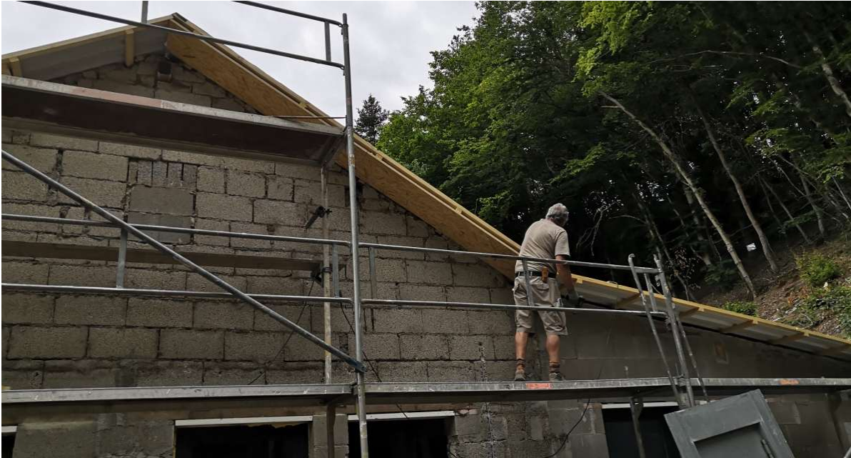
18.07.2020 Lothar Krupp beim verkleiden des neuen Dachüberstandes. Foto: Frank Marten
