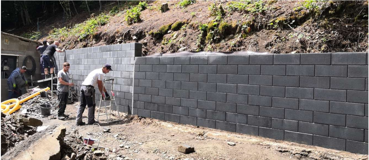
06.06.2020 Wilfried Lescher, Andreas von Ameln, Daniel Lux, Tobias Schneider und Kevin Götten beim betonieren der Schalmauer. Foto: Frank Marten
