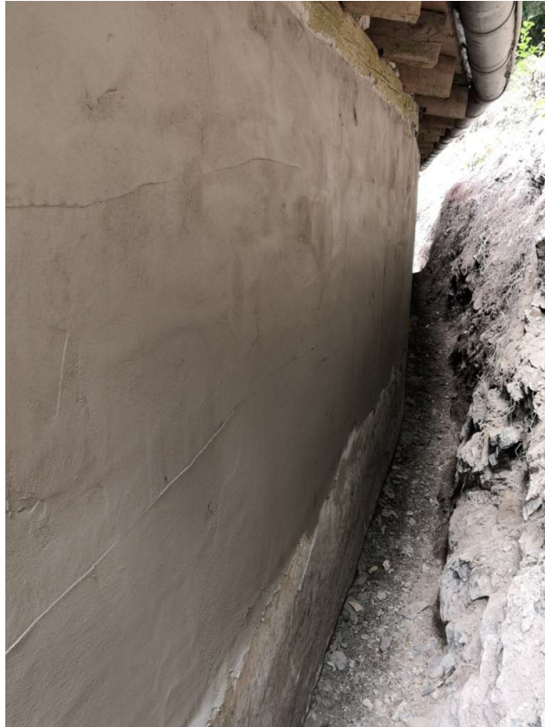
26.05.2020 Graben hinter dem Gebäude und neu verputzt von Marc Hohns. Foto: Frank Marten
