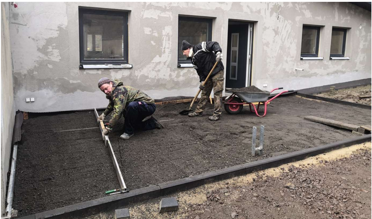
12.12.2020 Andreas von Ameln und Lutz Musiol beim pflastern der Terrassenfläche im alten Schießstand. Hier wird schwarzer Sand aus Gillenfeld, aus der Sandkaul von Helmut Keil am Pulvermaar als Pflasterbett verbaut. Foto: Frank Marten
