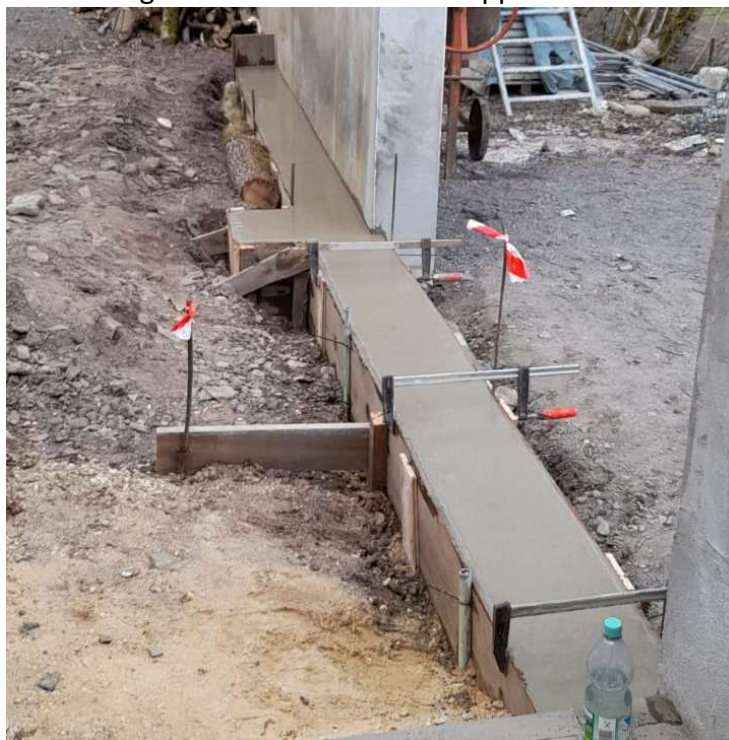
26.03.2021 Das Fundament für das Schiebetor wurde betoniert. Foto: Lothar Krupp
