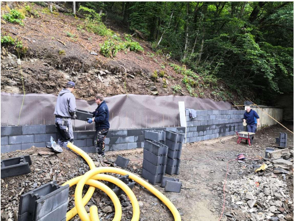
06.06.2020 Kevin Götten, Tobias Schneider und Daniel Lux beim Bau der Schalmauer im Schießstand. Foto: Frank Marten
