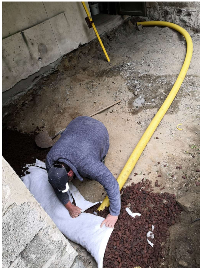
28.04.2020 Marc Hohns beim verlegen der Dränage unter der neuen Küche. Foto: Frank Marten.
