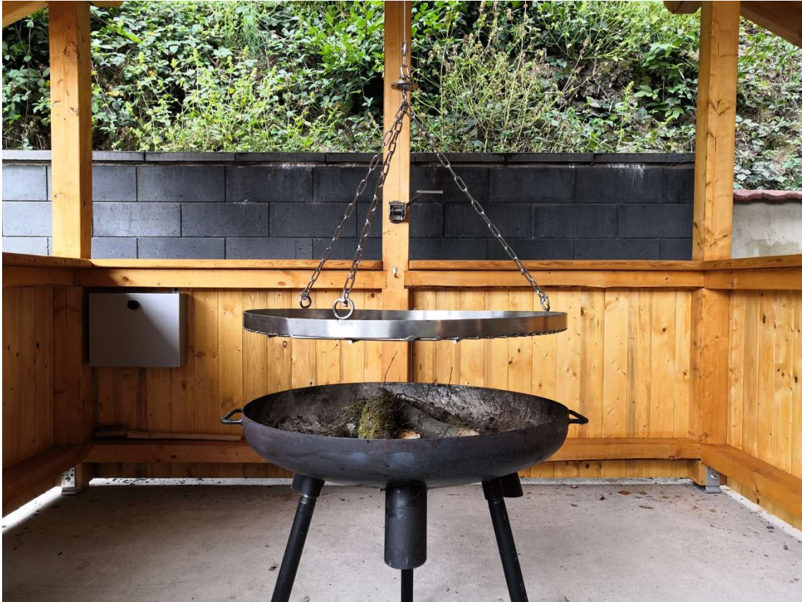
11.09.2021 Die Montage des Kugelgelagerten Schwenkgrills in der Grillhütte. Foto: Frank Marten
