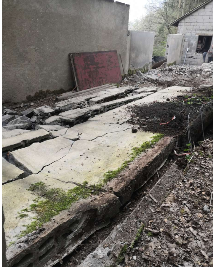
18.04.2020 Die letzte gefallene Kugelschutzmauer im Schießstand. Foto: Frank Marten
