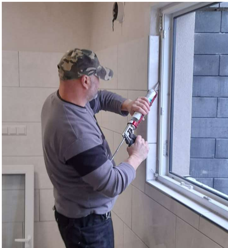
08.01.2021 Emil Hermann beim ausspritzen der Fugen mit Silikon in der Küche
