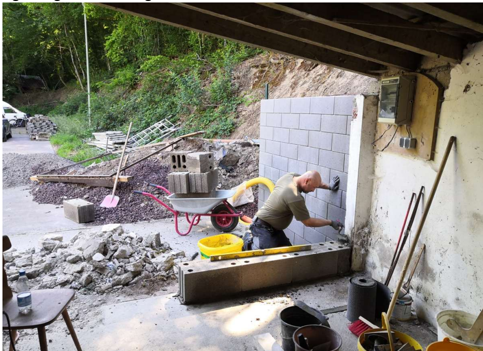
23.06.2020 Emil Hermann beim zumauern der alten Toröffnung vom alten Schuppen. Foto: Frank Marten
