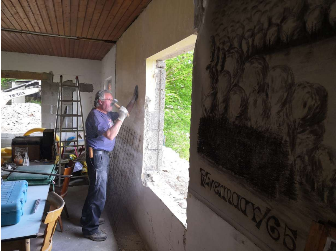
08.05.2020 Lothar Krupp beim ausbau der alten Fenster. Foto: Frank Marten
