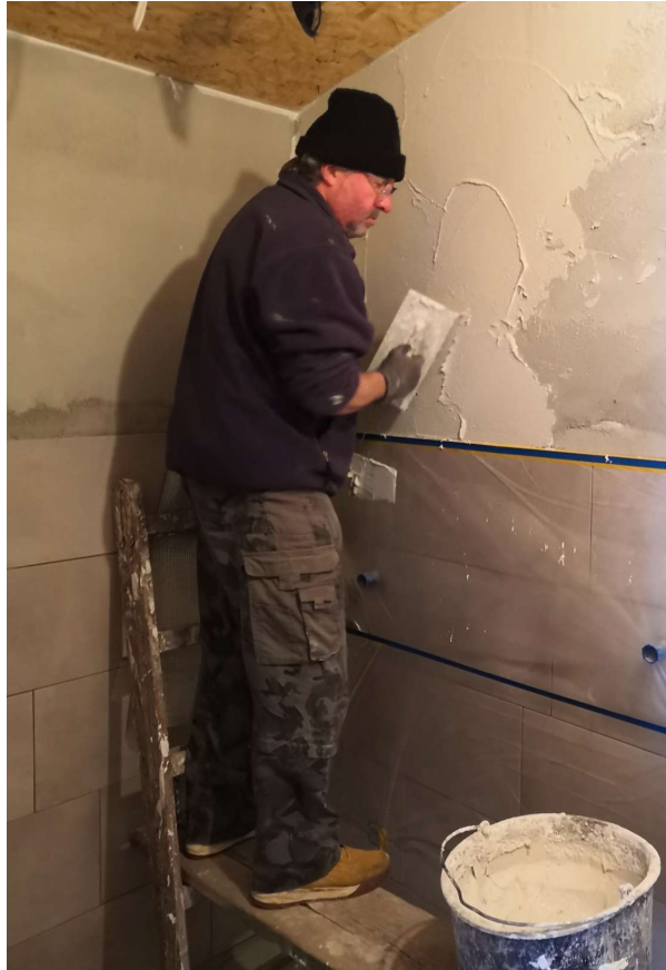
26.01.2021 Lothar Krupp beim einziehen des Gewebes im WC mit SM 700 Pro um die Verbindungsrisse der verschiedenen Mauerwerke zu überbrücken.
