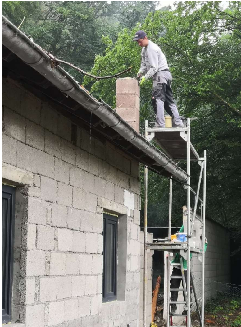
09.06.2020 Kevin Götten und Tobias Schneider beim setzen des neuen Schornsteines. Foto: Frank Marten
