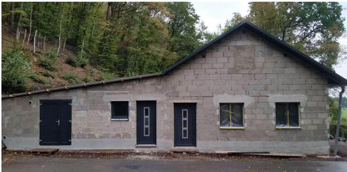
02.10.2020 Alle neuen Außentüren sitzen, es kann verputzt werden. Foto: Lothar Krupp
