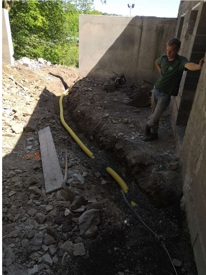
16.05.2020 Jonas Zimmer beim verlegen der Dränage und des Erdbandes im Schießstand. Foto: Frank Marten
