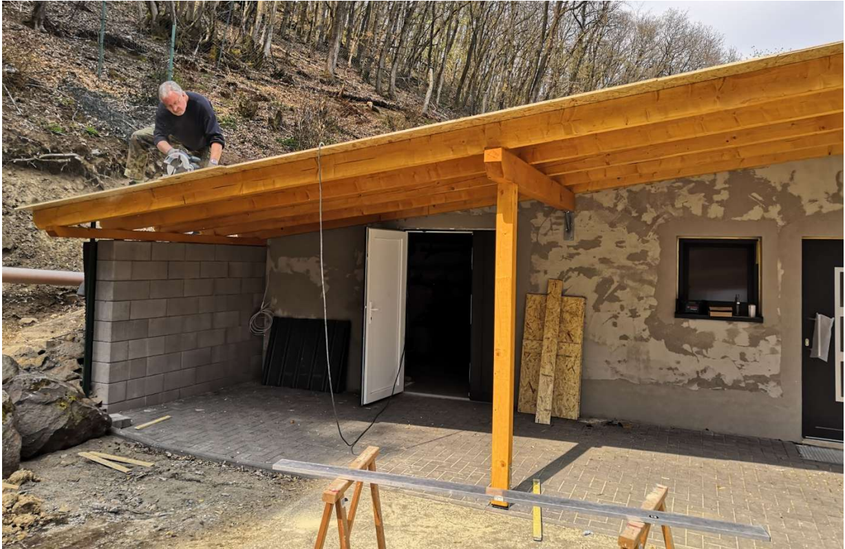
21.04.2021 Lothar Krupp beim zuschneiden der Dachfläche des Vorbaus. Foto: Frank Marten
