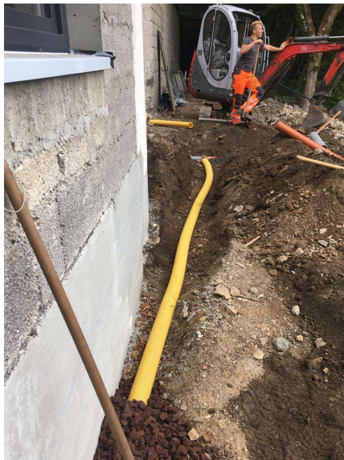
02.09.2020 Jonas Zimmer beim Einbau der Dranage zur Talseite. Foto: Michael Zimmer
