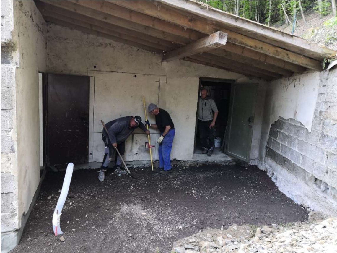
28.04.2020 Einbau des Lavaunterbau für die Bodenplatte. Von links: Marc Hohns, Walter Daniel und Daniel Lux. Foto: Frank Marten.
