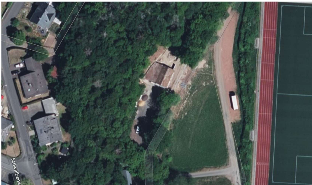
Satellitenbild des alten Schützenhauses mit alter Bedachung nach Freilegung. Quelle: Bing
