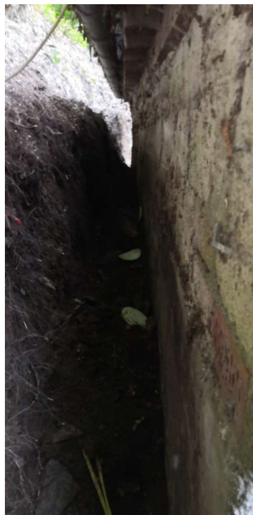
18.05.2020 Graben zur Lay. Foto: Frank Marten
