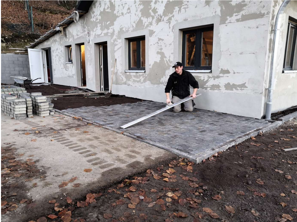
27.11.2020 Maik Thome beim pflastern der Vorfläche. Foto: Frank Marten
