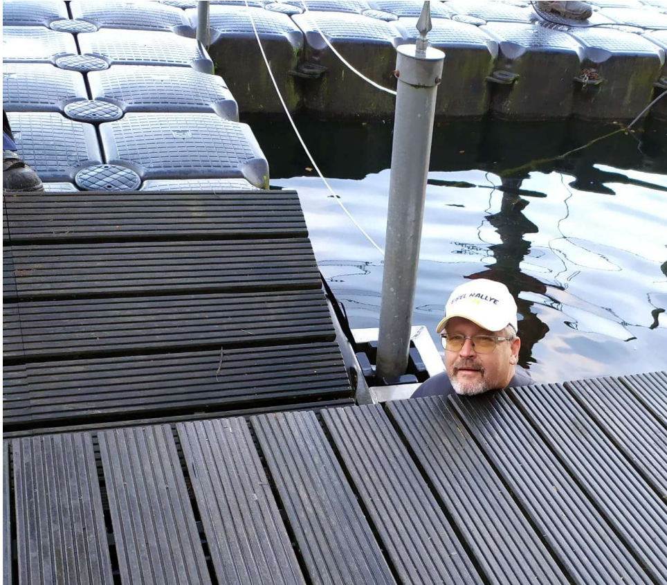
28.09.2024 Andreas Nohn beim demontieren der Rampe für auf den Schwimmsteg. Foto: Frank Marten Durch den steigenden Wasserspiegel drückte die Rampe gegen die Potons und wurde damit zum Hindernis.
