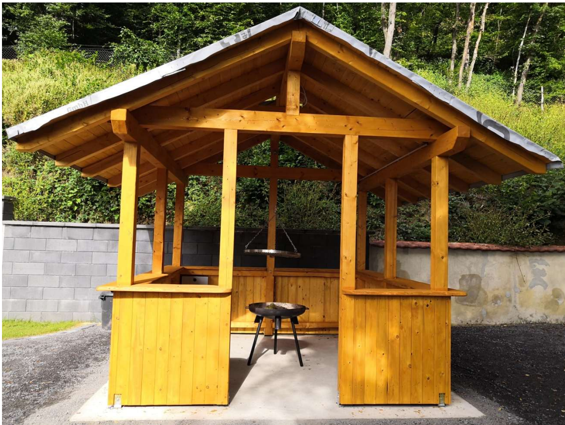
11.09.2021 Die grillbereite Grillanlage des AVG. Es fehlt nur noch die Dacheindeckung. Foto: Frank Marten
