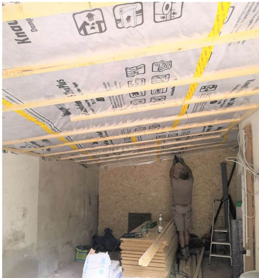
03.08.2020 Lothar Krupp beim abhängen der Decke im Lagerraum. Foto: Frank Marten
