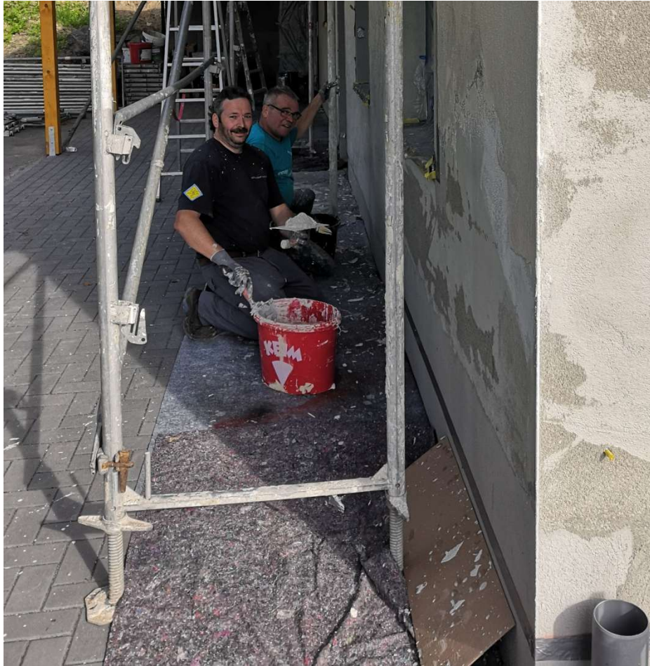
12.06.2021 Andreas Willems und Michael Zimmer beim auftragen des Feinputzes mit SM700 Pro. Foto: Frank Marten
