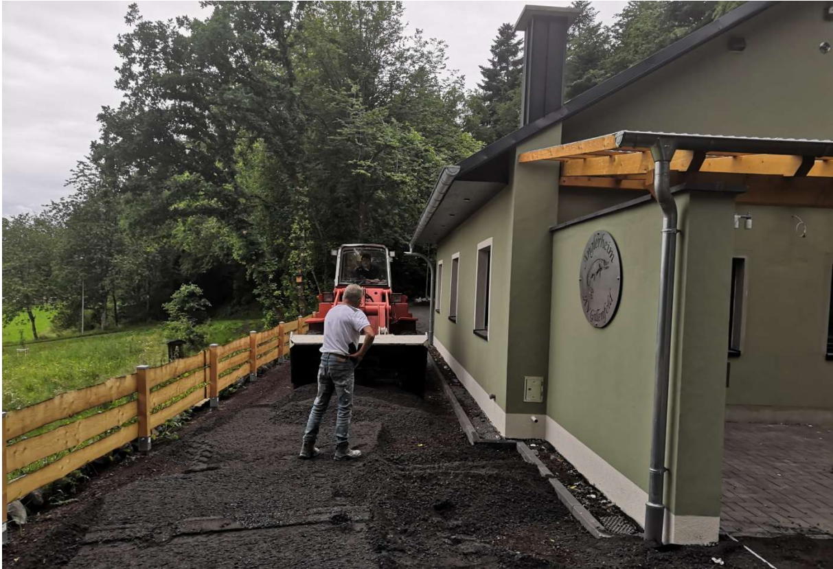
30.06.2021 Michael Zimmer und Thomas Mertes im Radlader, beim einbauen des Basaltsplittes auf dem Weg zum Grillplatz. Foto: Frank Marten
