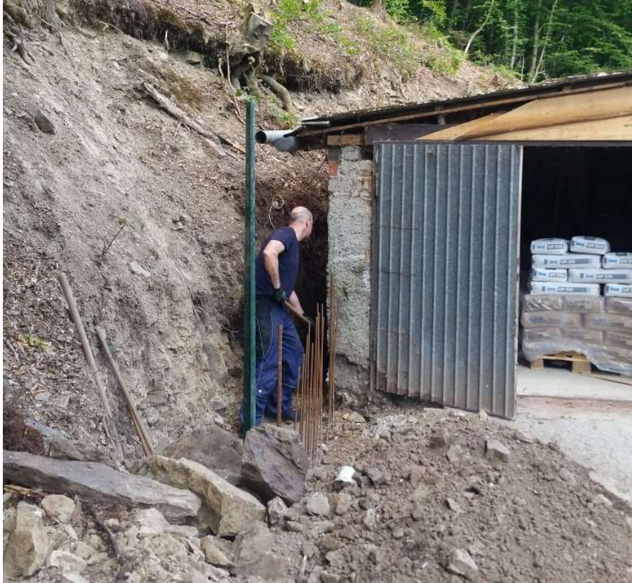
18.05.2020 Frank Marten beim Ausschachten der Hinterwand zur Lay. Foto: Lothar Krupp
