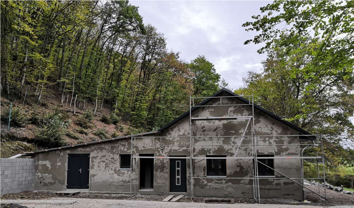
19.10.2020 Ansicht nach dem verputzen. Foto: Frank Marten
