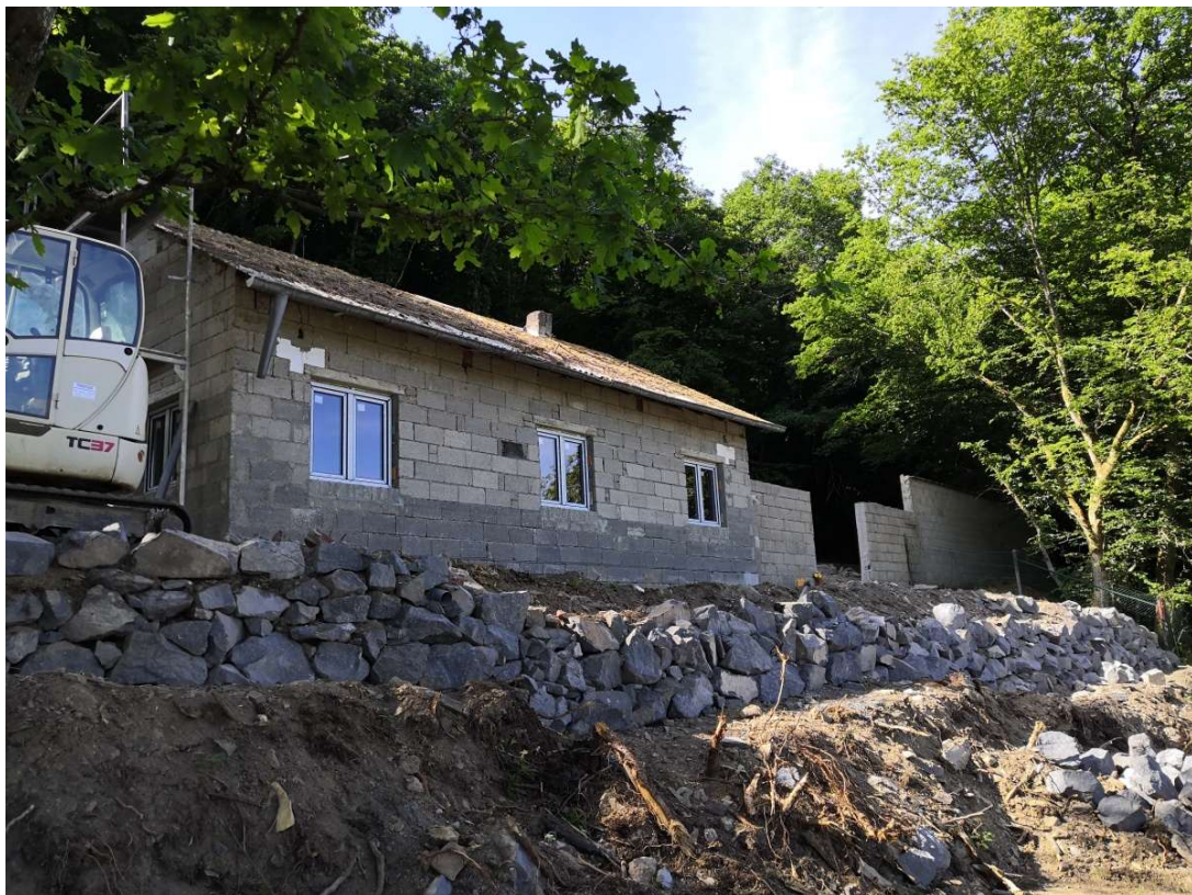
02.06 2020 Neue Fenster sind montiert, die Natursteinmauer wächst. Foto: Frank Marten
