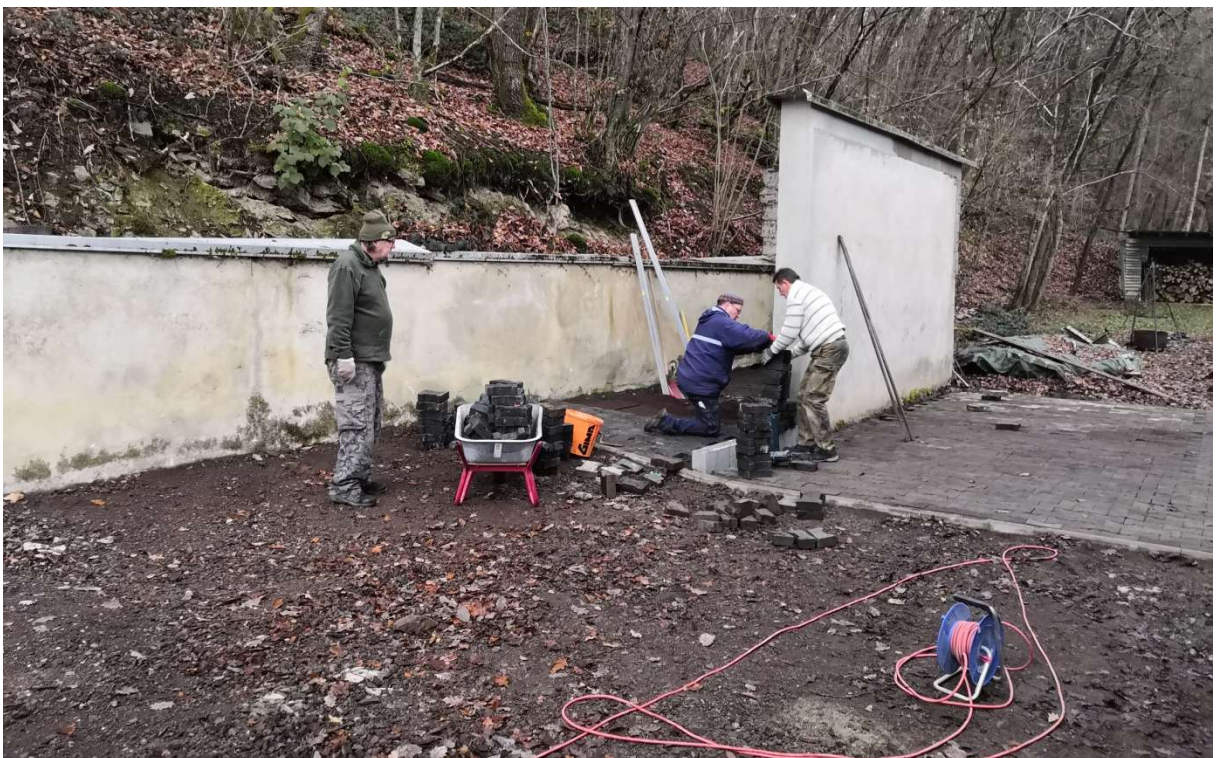
02.12.2020 Wolfgang Thiel, Andreas von Ameln und Lutz Musiol beim pflastern im alten Schießstand. Hier wurde das alte Pflaster von der Vorfläche sowie Pflastersteine die im Schießstand gelagert wurden wieder eingebaut. Foto: Frank Marten
