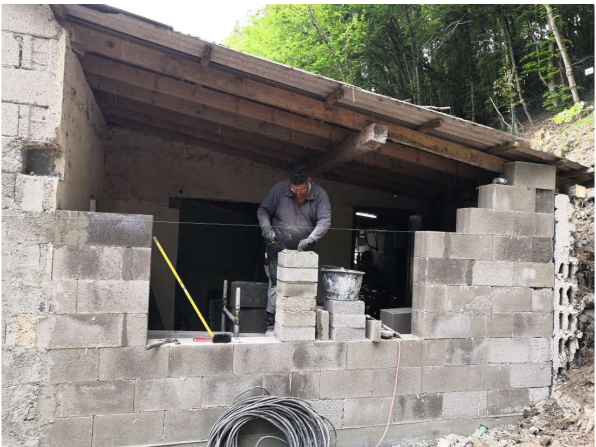
Marc Hohns beim mauern der Küche. 05.05.2020 . Foto: Frank Marten
