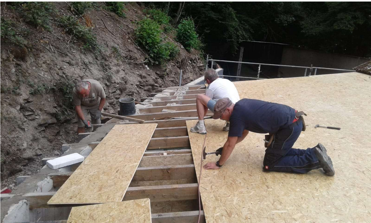
03.07.2020 Lothar Krupp beim ausmauern der Sparren. Michael Zimmer und Frank Marten beim zu legen des Pultdaches mit OSB. Foto: Thomas Schneider
