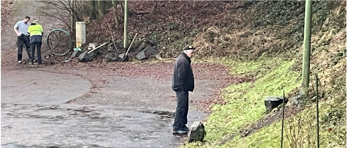
Maik Thome, Edo van Aert und Dirk Vosen beim einziehen des neuen Kabel in das Leerrohr. Foto: Frank Marten
