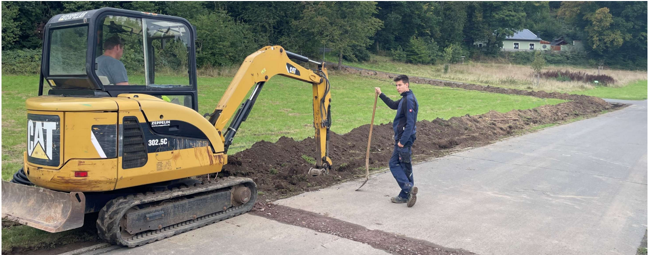
(Im Bagger: Maik Thome. An der Schaufel: Philipp Marten. Foto: Frank Marten)
