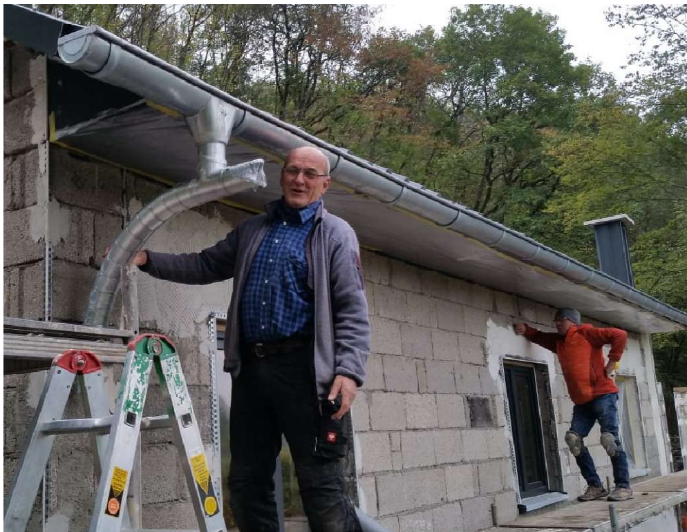
15.10.2020 Klaus Mayer beim anpassen des „Schweizer Rohrbogens“ an der Dachrinne. Hinten im Bild, Michael Zimmer. Klaus Mayer fertigte diesen Rohrbogen, den auch noch ein Fischkopf zierte, in Handarbeit an. Klaus ist kein Mitglied des AVG, umso mehr freute sich der Verein über seine Unterstützung. Foto: Lothar Krupp
