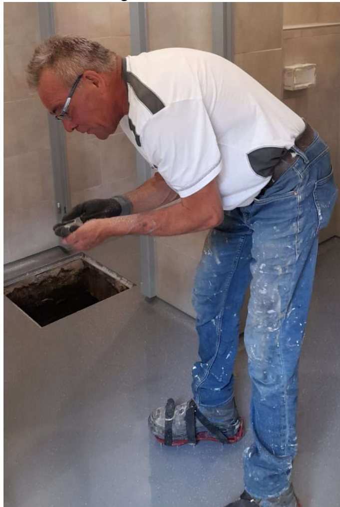
11.06.2021 Michael Zimmer beim beflocken der Bodenbeschichtung im WC. Foto: L. Krupp
