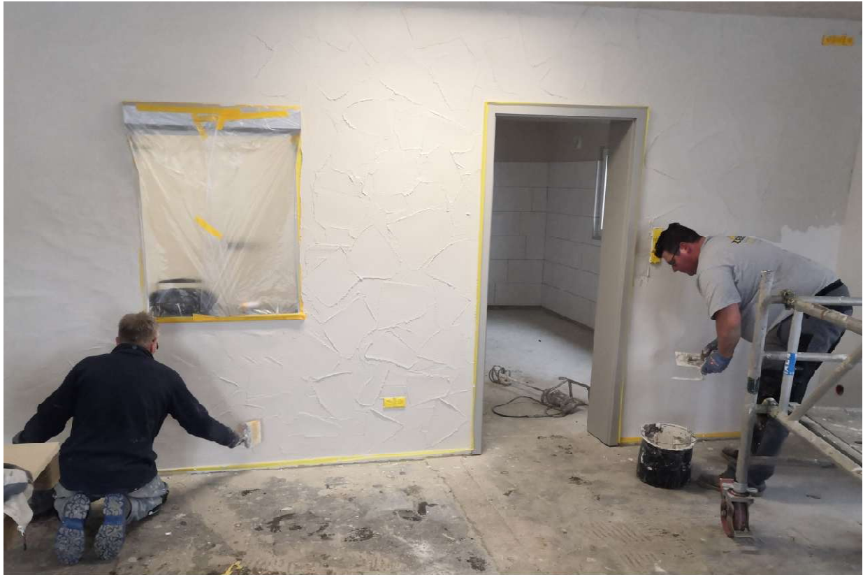
05.01.2021 Michael Zimmer und Marc Hohns beim Verputzen des Innenraumes mit SM 700 PRO. Foto: Frank Marten
