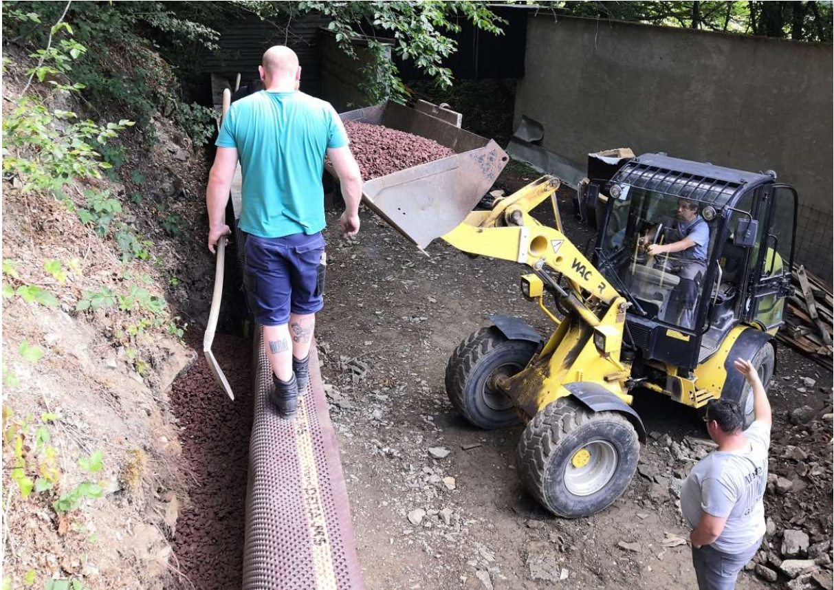
13.06.2020 Daniel Lux, Thomas Ternes und Marc Hohns beim verfüllen der Schalmauer mit Lava. Foto: Frank Marten
