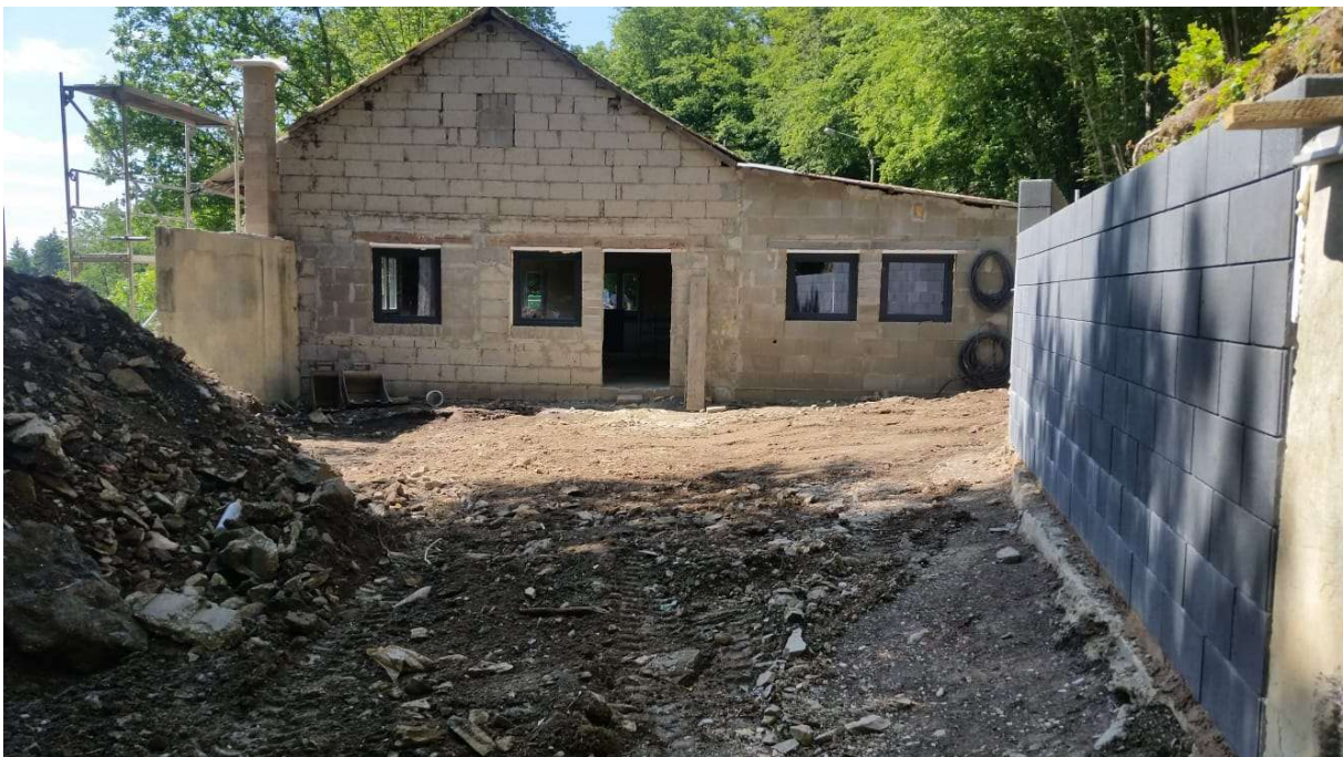
13.06.2020 Die fertige Schalmauer, neue Fenster und neuer Schornstein. Foto: Lothar Krupp
