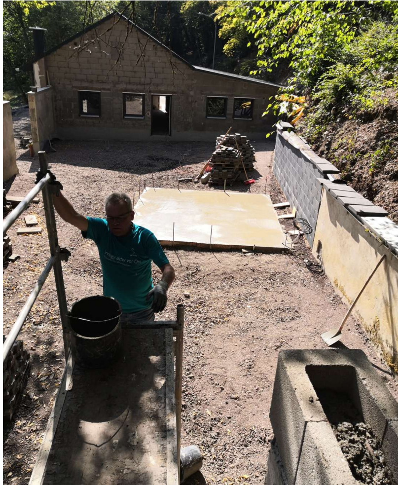
19.09.2020 Michael Zimmer beim betonieren der Ringanker. Foto: Frank Marten
