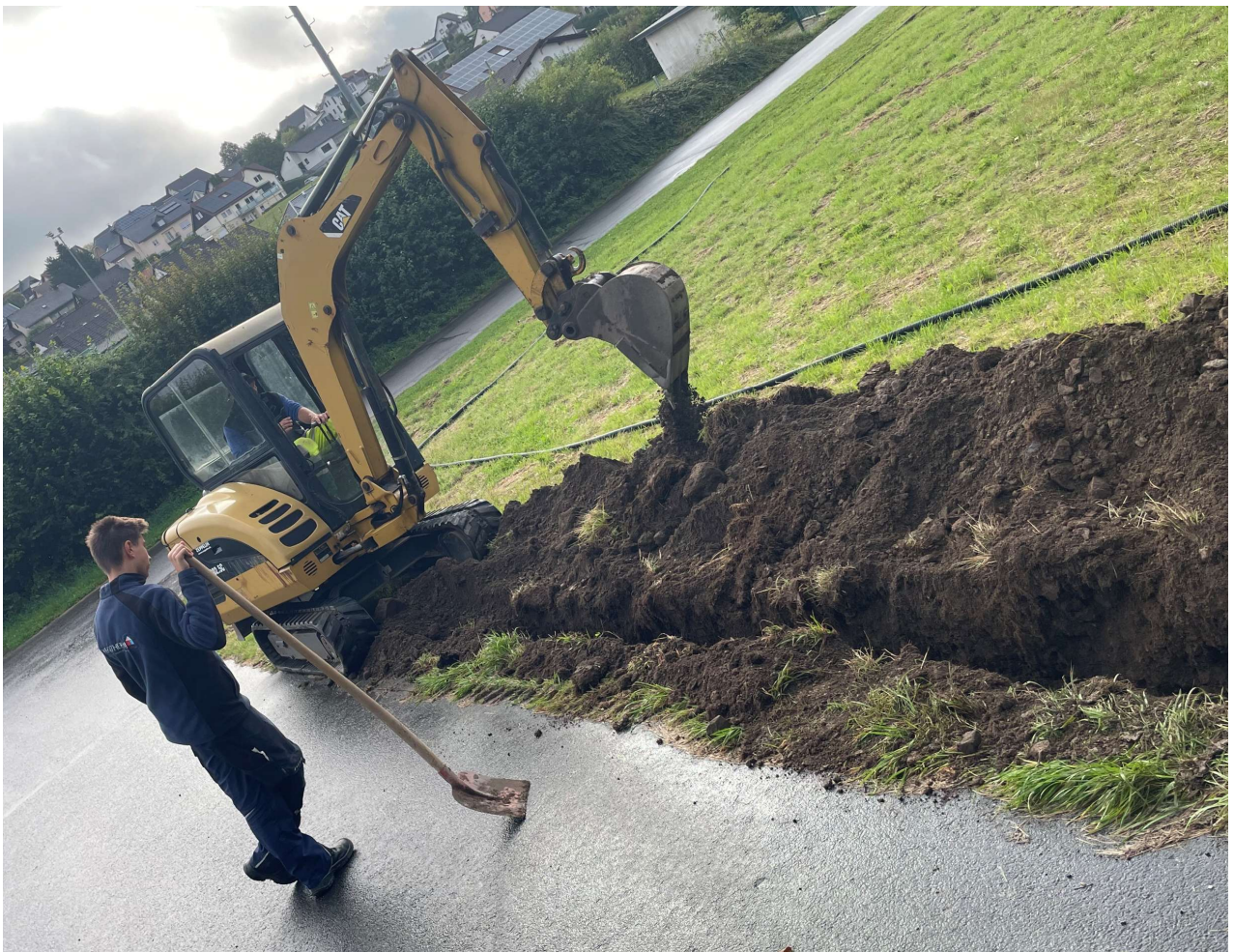
(Im Bagger: Maik Thome. An der Schaufel: Philipp Marten. Foto: Frank Marten)
