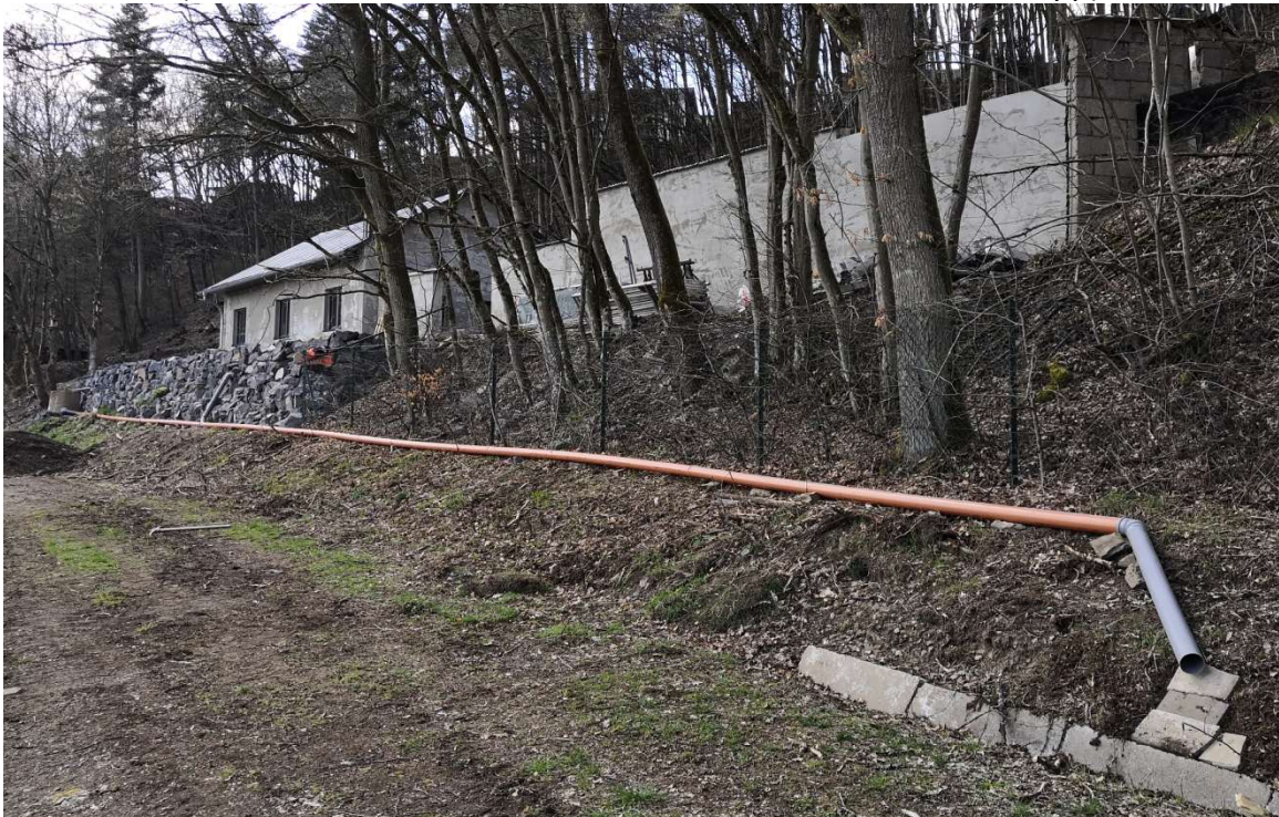
08.04.2021 Die Abwasserleitung für das Regenwasser in die Laubach. Länge im unteren Bereich: 42m. Foto: Frank Marten
