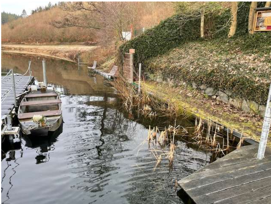
01.02.2025 Wie der Rettungssteg gebaut wurde, war der Wasserstand so tief, dass wir mit Gummistiefeln die Stützen montieren konnten. Foto: Frank Marten
