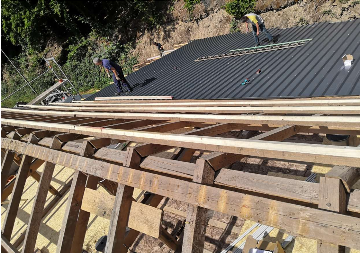
11.07.2020 Dacharbeiten. Von links Thomas Schneider, Lutz Musiol, Michael Lamberty. Die Lattung auf der Rückseite musste aufgedoppelt werden mit 4/6er Latten. Foto: Frank Marten
