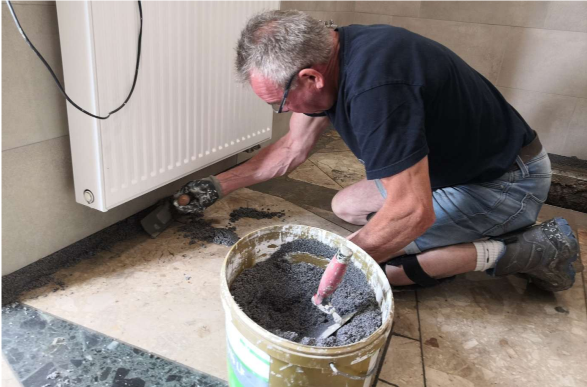
09.06.2021 Michael Zimmer beim fertigen der Hohlkehlen im WC. Foto: Frank Marten
