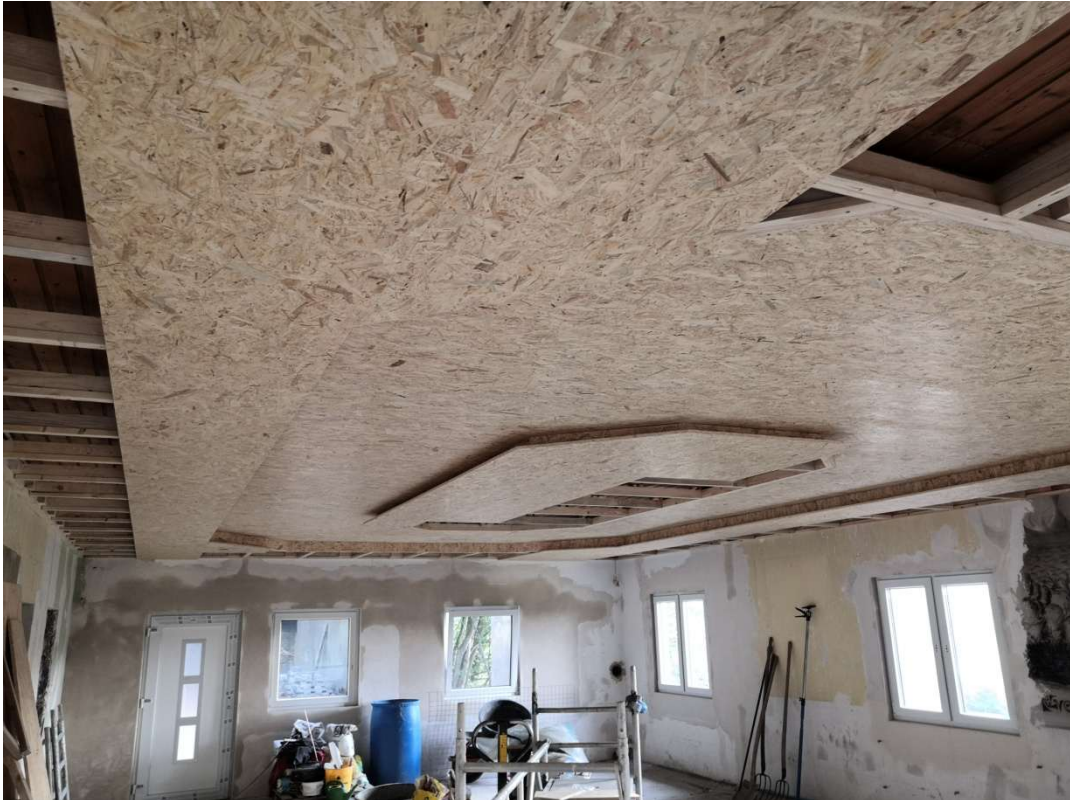
05.09.2020 Bau der OSB-Decke im Mehrzweckraum. Wand zum Schießstand, sowie die Fensterleibungen innenseitig sind schon beigeputzt mit Rotband. Wenn man alle Decken, die Speicherdecke, sowie die Dachschalung auf dem Pultdach nur von dem Gebäude berücksichtigt, so sind gut 3t OSB3 15mm Platten verbaut worden. Foto: Frank Marten
