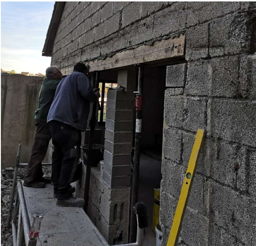
24.04.2020 Hochsetzen des Holzsturzes. Hinten Lothar Krupp, vorne Mark Hohns. Foto: Frank Marten
