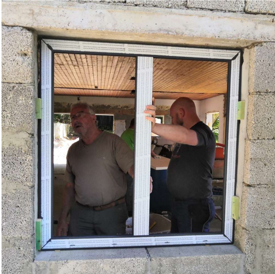
02.06.2020 Lothar Krupp und Daniel Lux beim Einbau der neuen Fenster. Foto: Frank Marten
