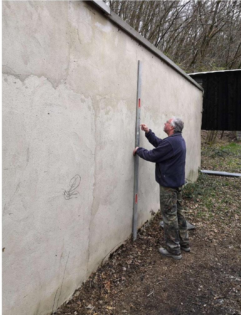
03.04.2020 Lothar Krupp beim anzeichnen der Mauer für den Abriss. Foto: Frank Marten
