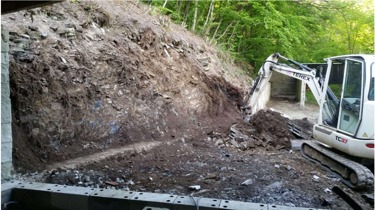
04.05.2020 Abriss der alten Mauer im Schießstand. Unten im Bild sieht man die neue Außenmauer der Küche. Foto: Frank Marten
