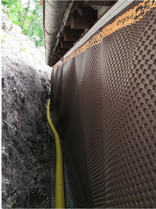
10.06.2020 Der Graben zur Lay vor dem verfüllen mit Lava. Foto: Frank Marten
