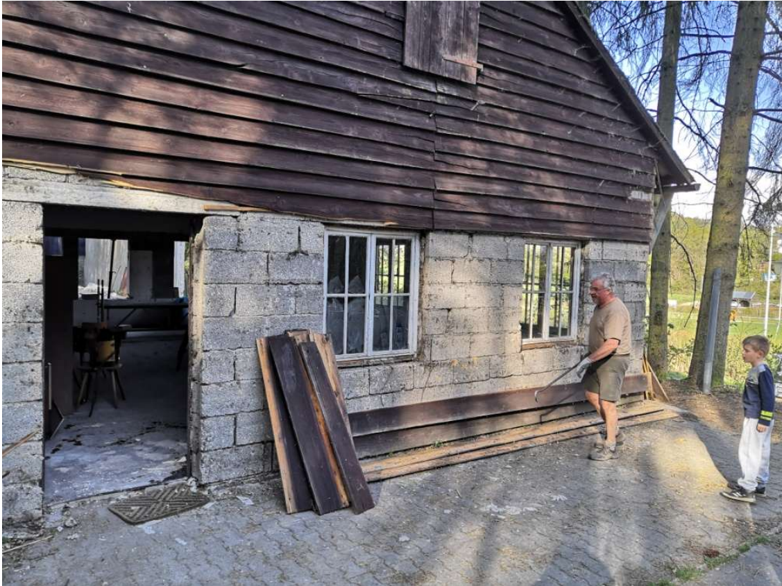
17.04.2020 Demontage der Holzverkleidung. Lothar Krupp u. Simon Marten. Foto: Frank Marten
