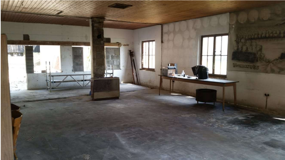
19.04.2020 Der Mehrzweckraum vor der Demontage des Ölofens und Schornstein. Foto: Frank Marten
