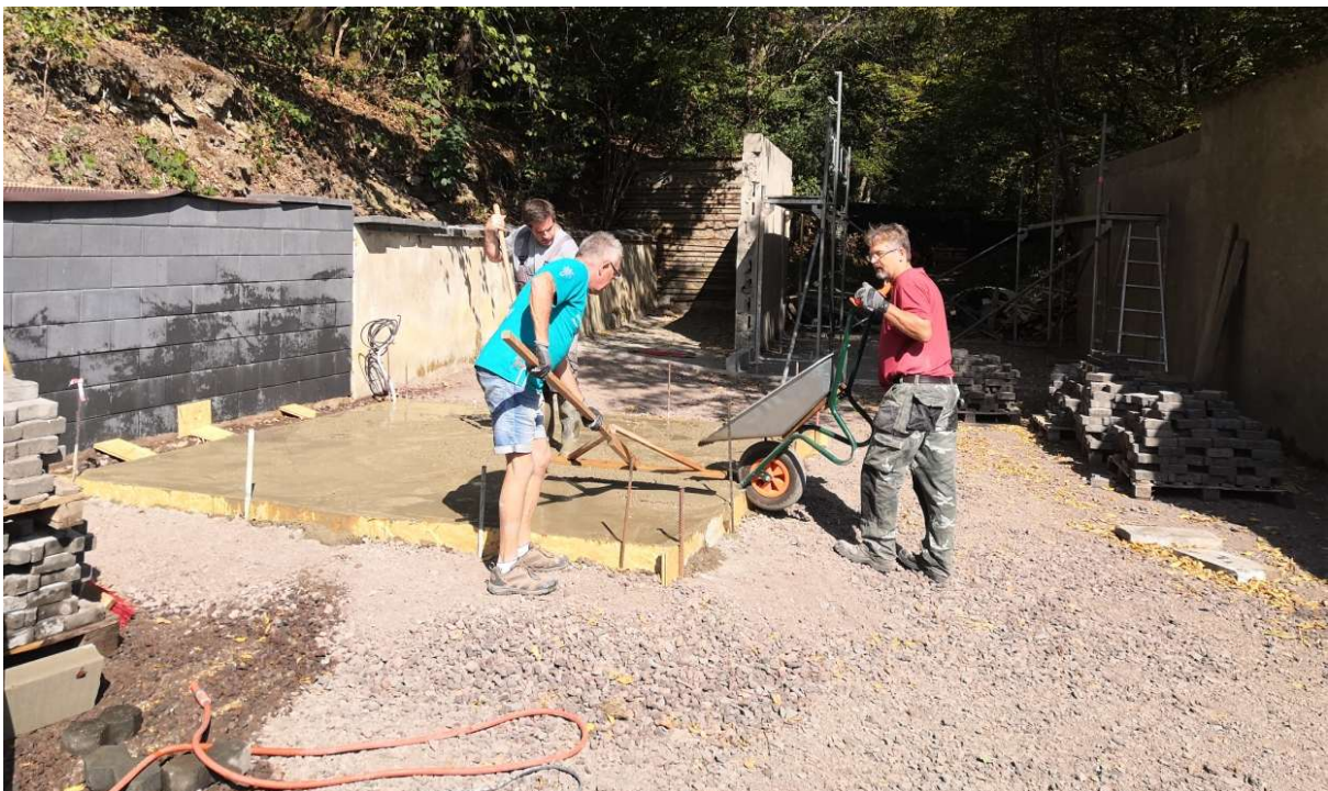
19.09.2020 Betonieren der Bodenplatte für die Grillhütte und den beiden Ringankern. Vorne Michael Zimmer, dahinter Thomas Ternes und rechts Andreas Nohn. Foto: Frank Marten
