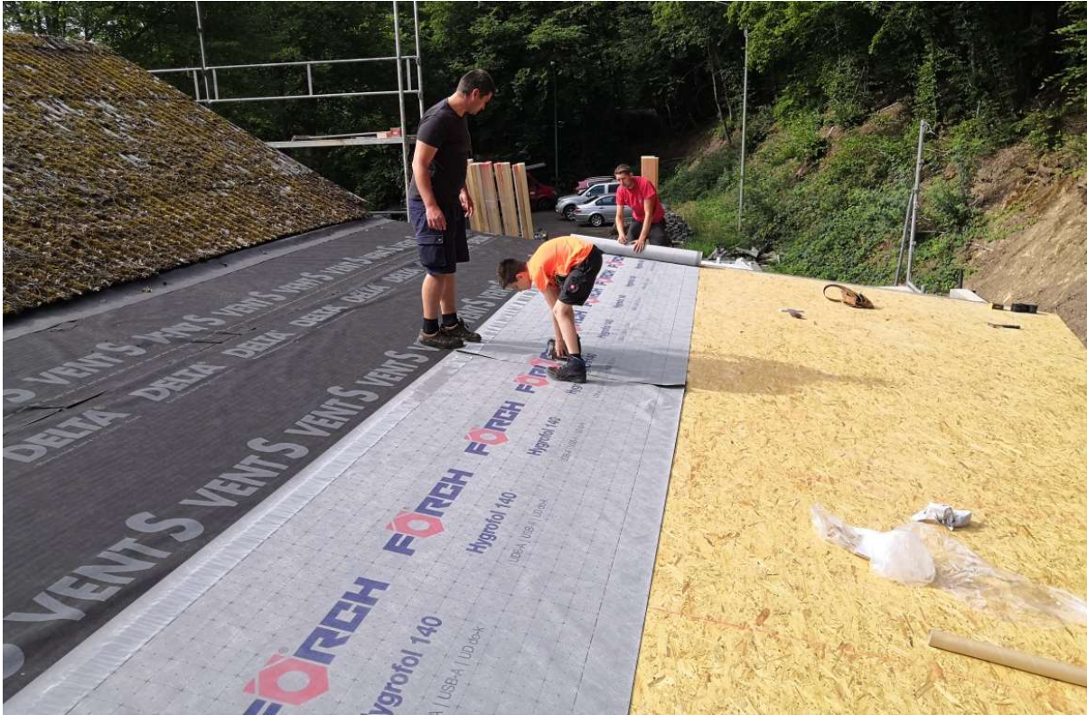
04.07.2020 Michael Lamberty, Philipp Marten und Christian Gräf beim befestigen der Unterspannplane des Pultdach. Foto: Frank Marten
