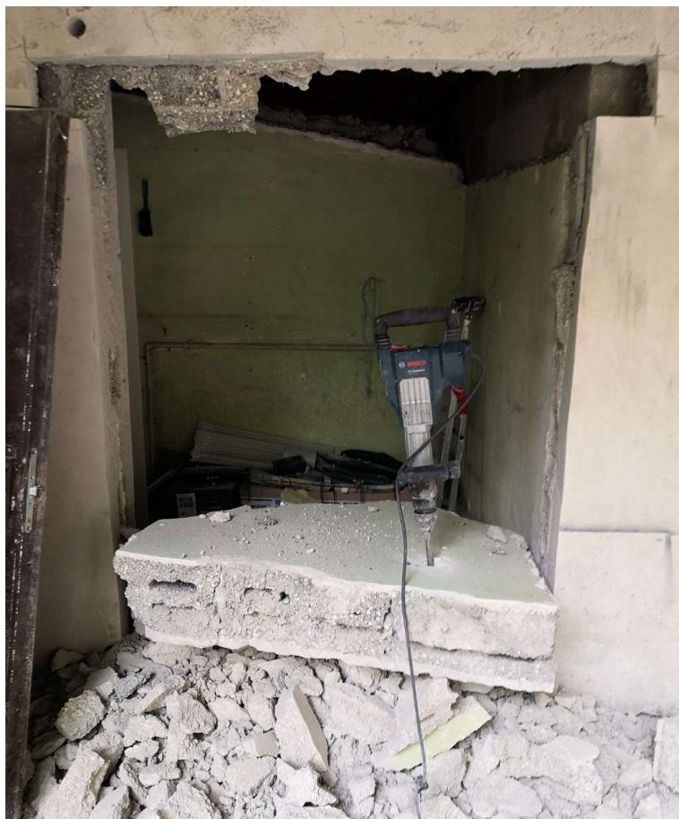
04.05.2020 Durchbruch zur Spülküche. Foto: Frank Marten
