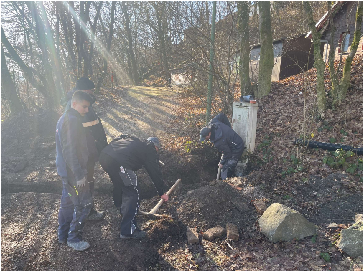
Philipp Marten, Emil Hermann, Andreas von Ameln und Maik Thome beim verlegen des Leerrohres für Kabel und Glasfaser. Foto: Frank Marten
