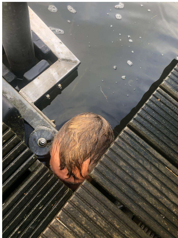
28.09.2024 Andreas Nohn musste unter Wasser um die Rampe zu demontieren. Foto: David Lux
