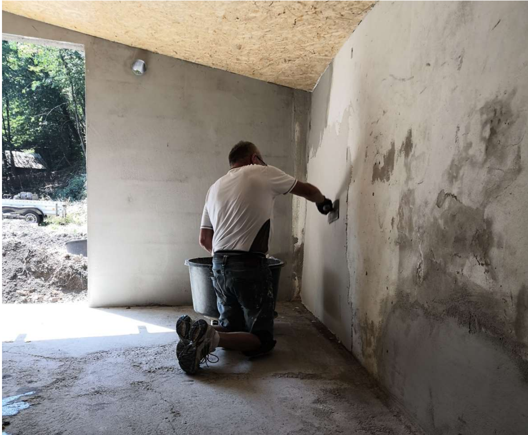
12.08.2020 Michael Zimmer beim verputzen des Lagerraumes. Foto: Frank Marten
