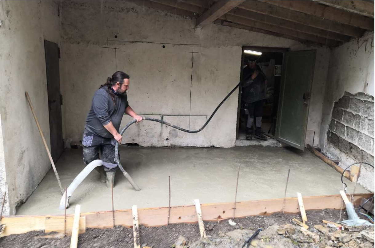
02.05.2020 Jan Daniel und Marc Hohns beim betonieren der Bodenplatte in der Küche. Foto: Frank Marten
