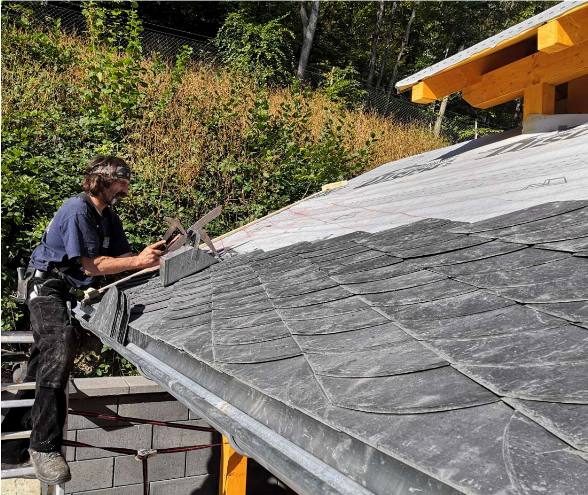
09.10.2021 Marco Heck (de Schwarzen) beim verschiefern der Grillhütte mit Naturschiefer. Foto: Frank Marten
